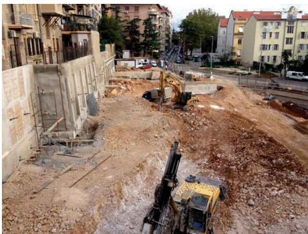
Pogled s druge strane na početak radova na iskopa građevne jame
