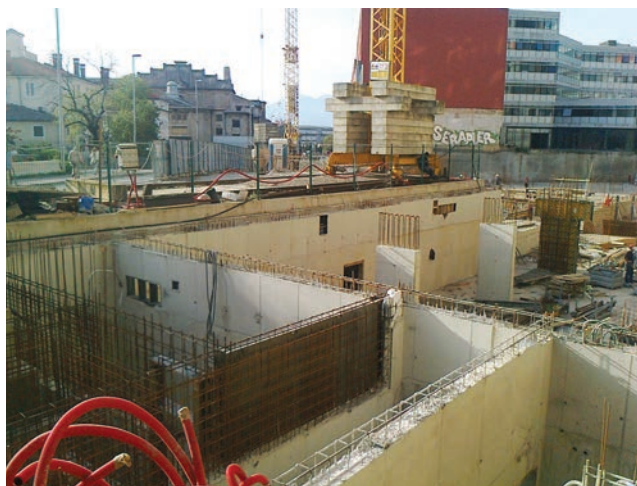
Detalj gradilišta pri kraju 2014. godine
