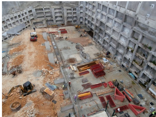
Pogled iz dizalice na gradilište
