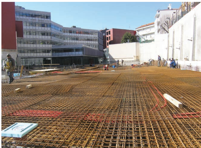
Armiranje završne krovne ploče
