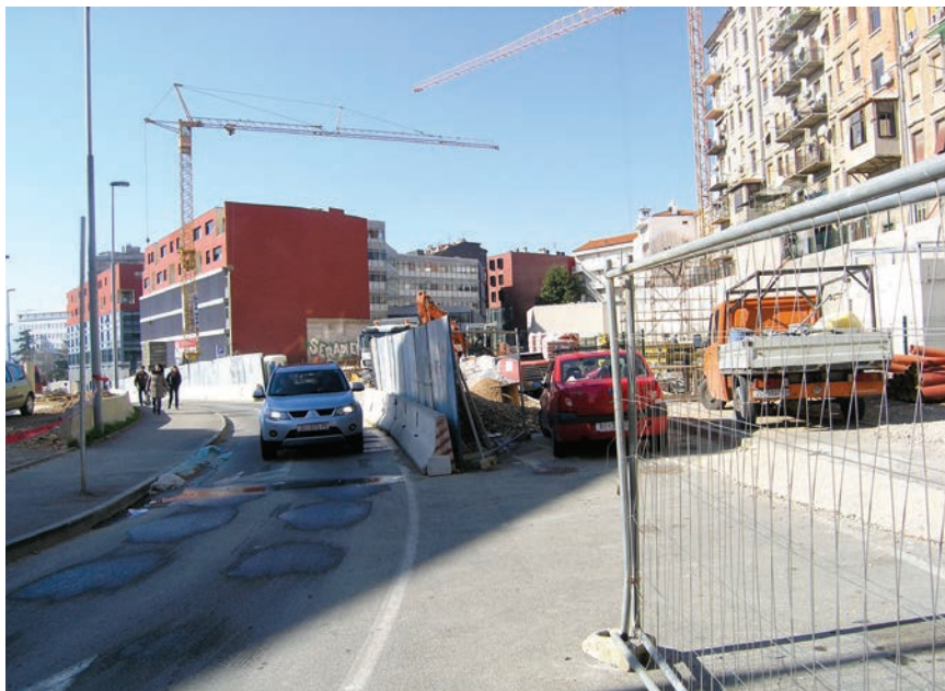
Ulaz u gradilište iz Ulice Ivana Pavla II
