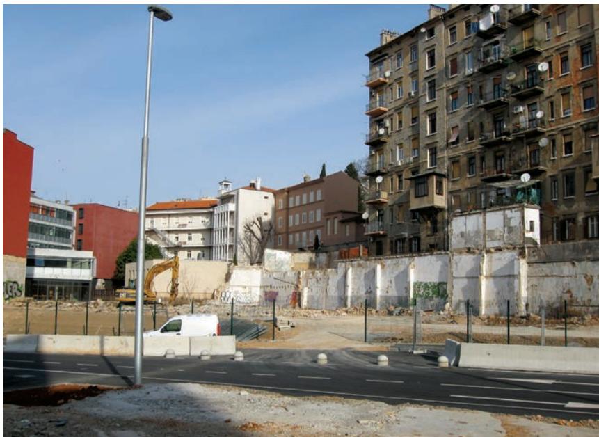
Početak radova na kopanju građevne jame
