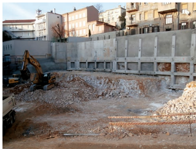
Detalj s početka iskopa
