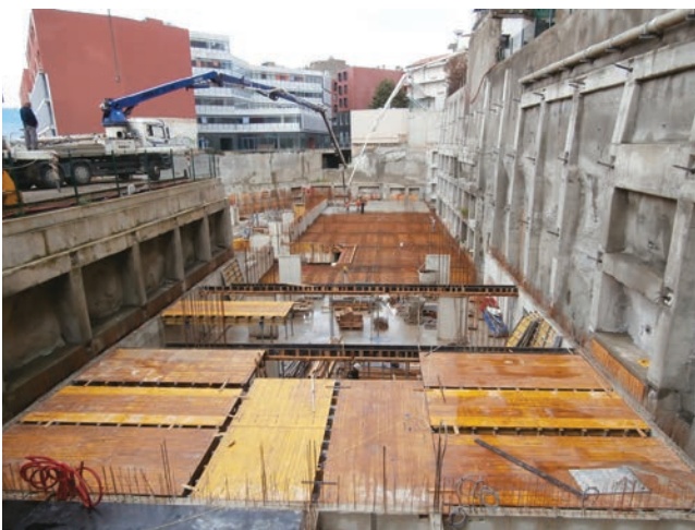
Uznapredovali radovi na gradnji garaže
