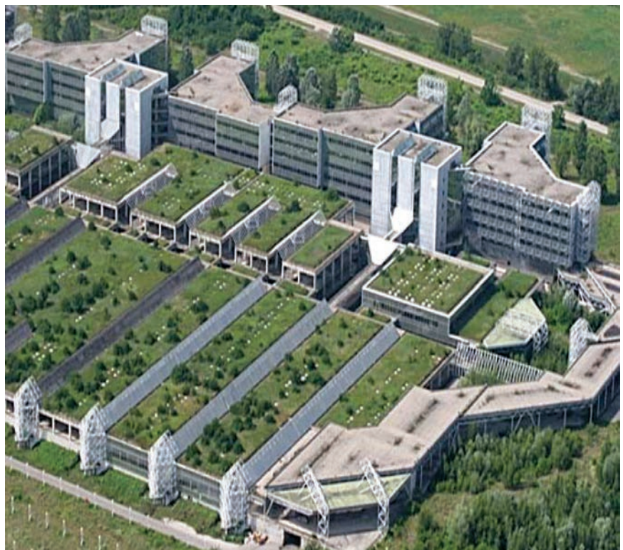
Dio napuštenog gradilišta iz zraka
