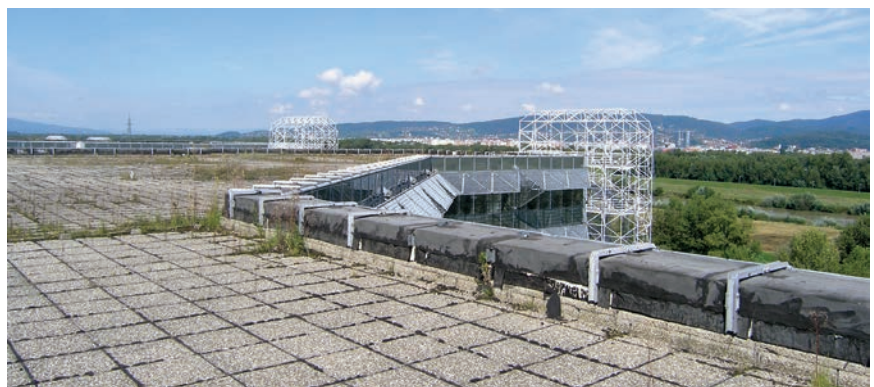
Krovne površine i dio grada na sjeverozapadu
