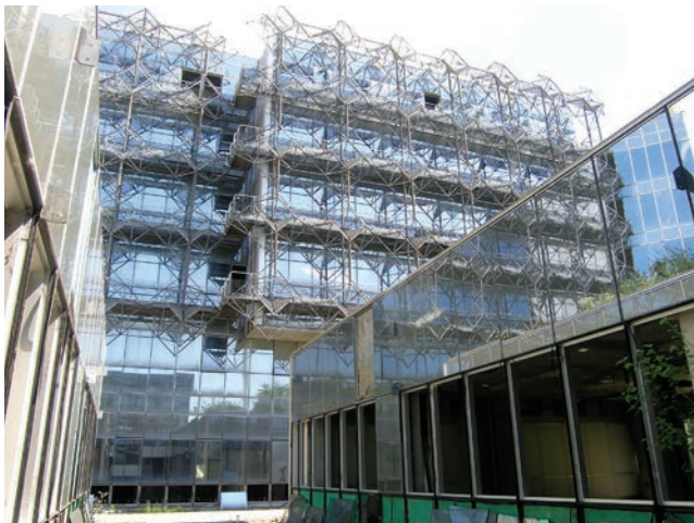
Dio pročelja stacionara
