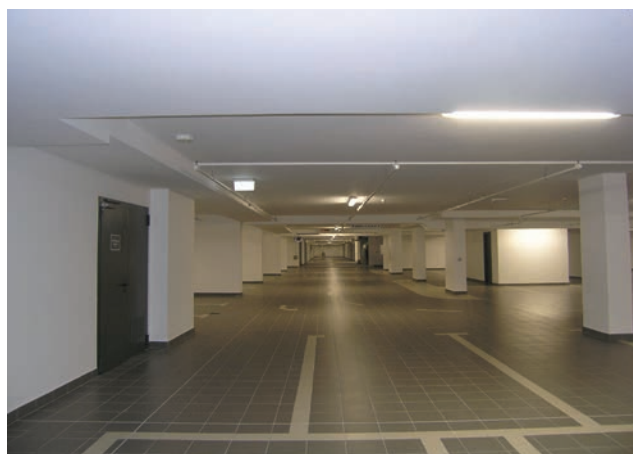
Dovršena podrumsko-garažna etaža
