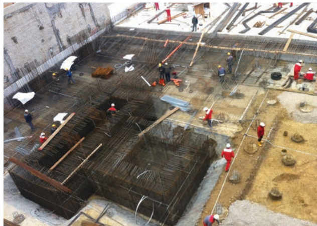
Početak armiranobetonskih radova u građevnoj jami (prosinac 2012.)
