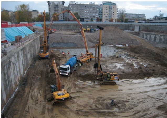
Rad u građevnoj jami i ojačavanje tla armiranobetonskim pilotima
