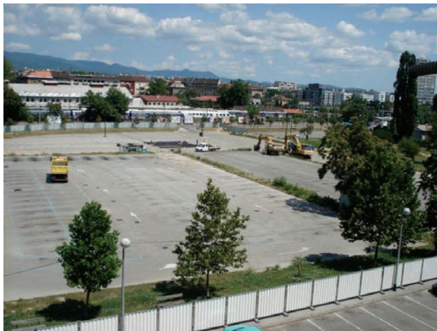
Prvi građevinski strojevi na gradilištu
