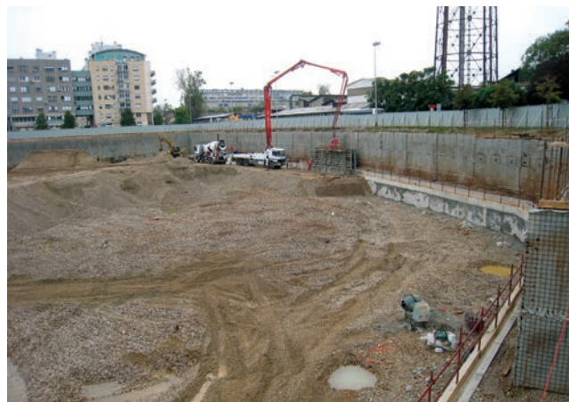
Iskop i zaštita građevne jame
