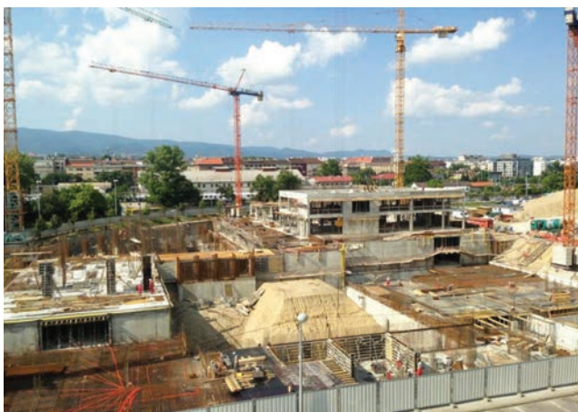
Uznapredovali armiranobetonski radovi (detalj iz srpnja 2013.)
