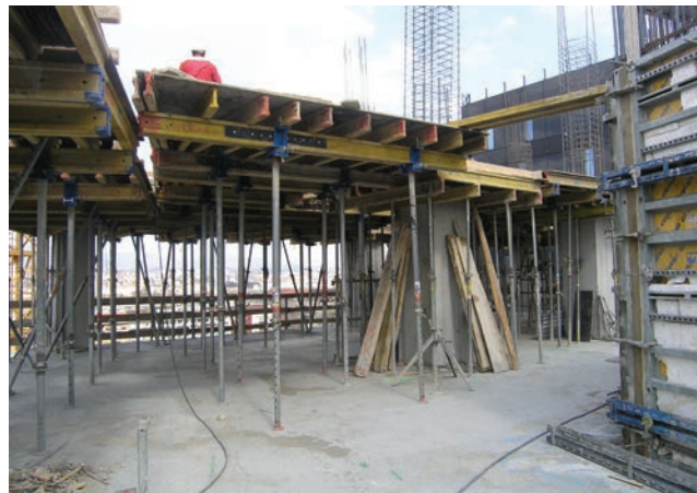
Betoniranje stropne ploče na najvišem neboderu
