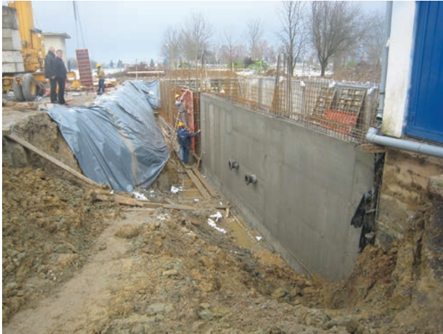
Gradnja podzemnog dijela nove strojarnice i filtrirnice (snimila: J. Pavletić)
