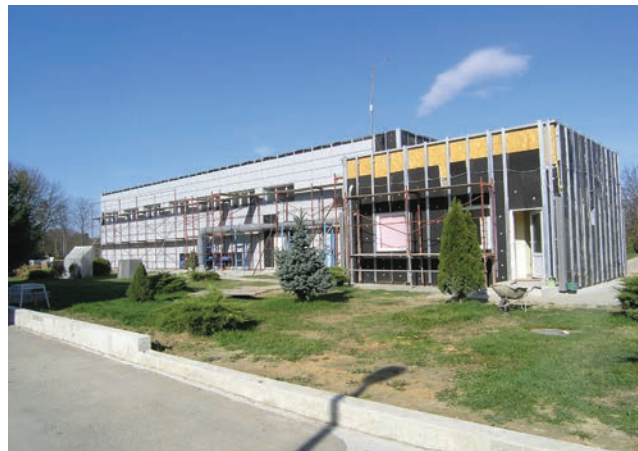
Nova strojarnica i filtrirnica snimljena tijekom posjeta
