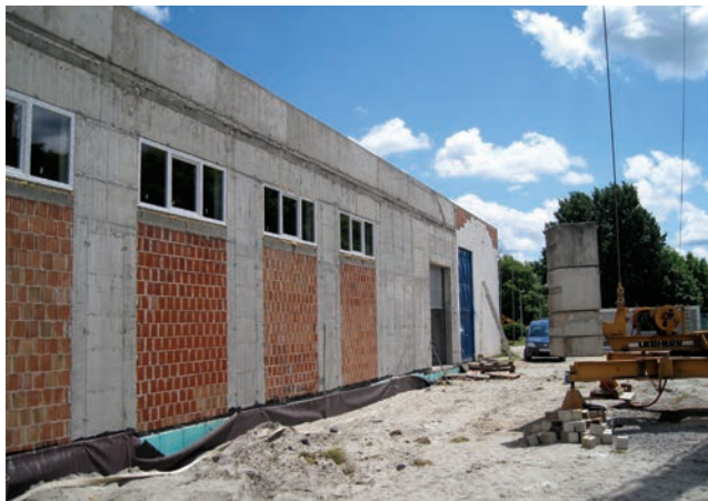
Građevinski radovi pri završetku (snimila: J. Pavletić)
