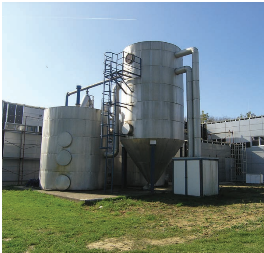
Novoizgrađeni i dograđeni dijelovi uređaja s dijelom pogona na otvorenom
