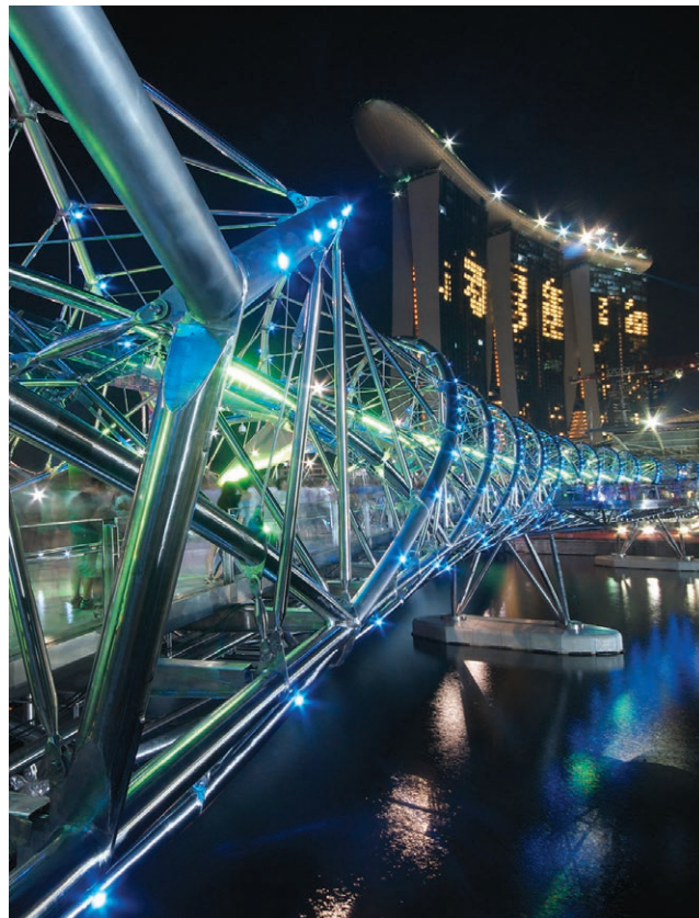
Helix bridge, pješački most u Singapuru
