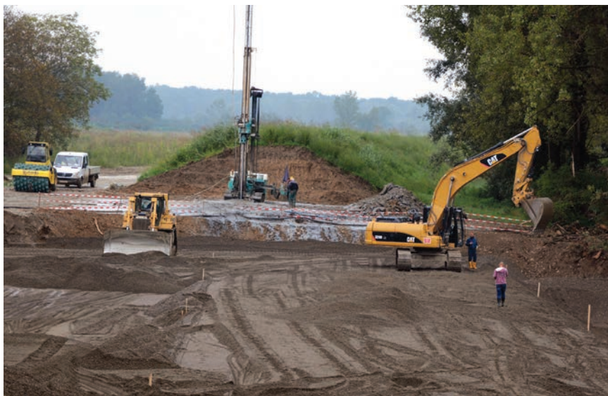
Radovi na sanaciji nasipa
