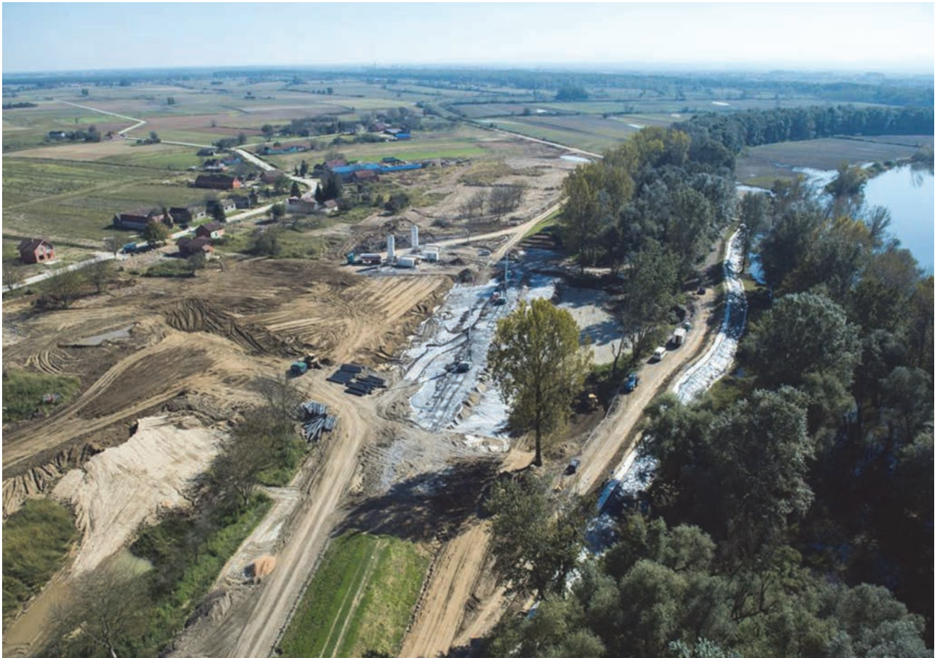
Avionski snimak radova na gradnji prednasipa i nasipa
