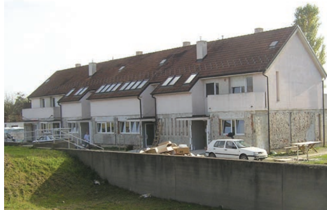
Obnova stradale ambulante
