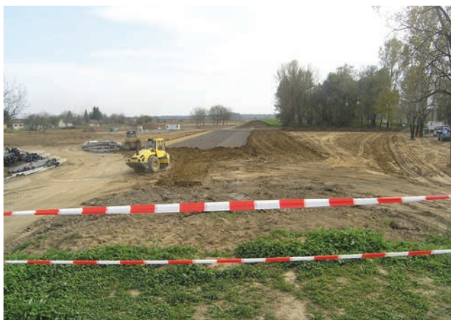
Radovi na nasipu u Rajevu Selu tijekom posjeta
