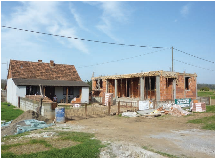
Gradnja jedne nove stambene zgrade u Rajevu Selu
