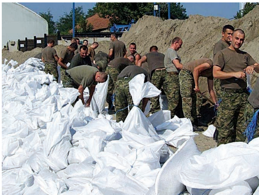
Vojnici u obrani od poplave
