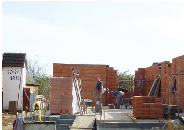
Gradnje jedne nove kuće na poplavljenom području
