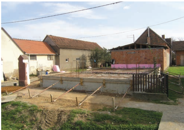
Temelji za gradnju nove kuće u Rajevu Selu
