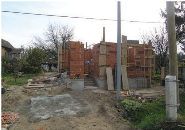
Gradnja još jedne nove kuće na poplavljenom području
