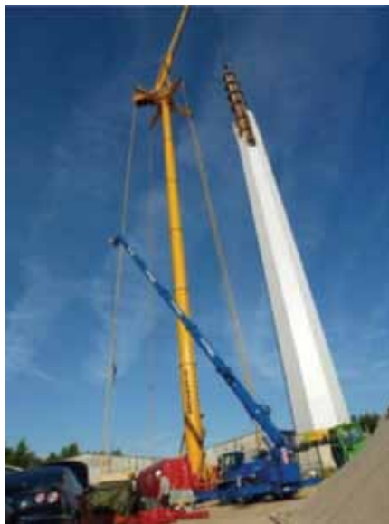
Oblaganje stupa predgotovljenim panelima
