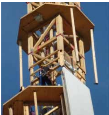
Gradnja drvene konstrukcije vjetrenjače
