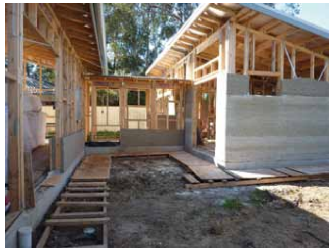
Gradnja blokovima od konoplje i vapna
