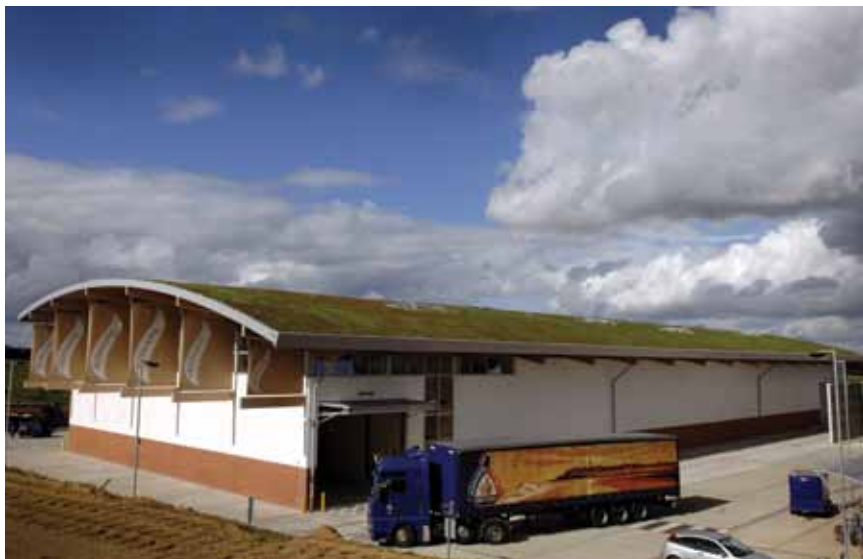
Skladište pivovare Adnams građeno je od 90.000 blokova od konoplje i vapna
