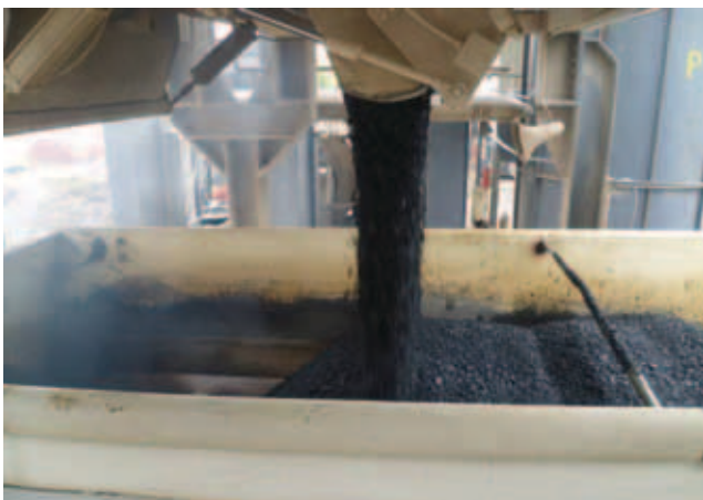
Slika 6. Pokusna proizvodnja asfaltne mješavine s 10 % recikliranog asfalta
