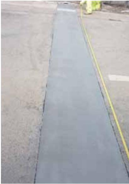
Detalj ugradnje nove prijelazne naprave
