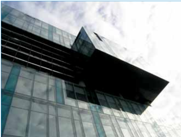
Detalj staklenoga pročelja snimljen tijekom posjeta
