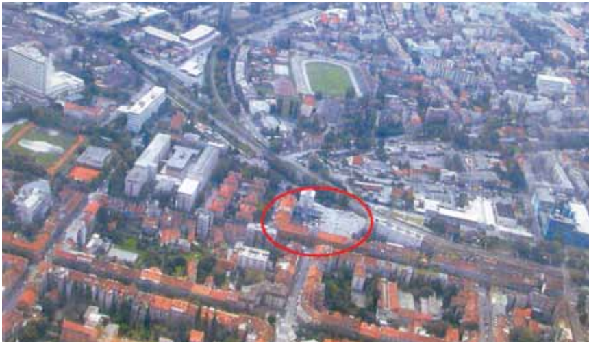
Pogled iz zraka na kompleks Tvornice duhana prije početka obnove
