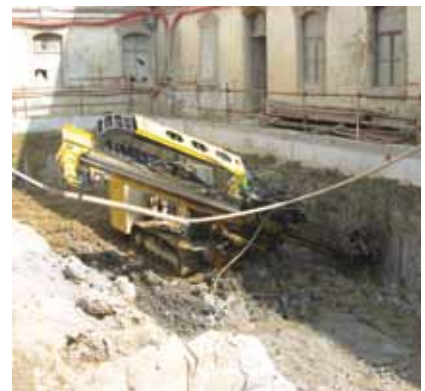
Radovi na iskopu i zaštiti građevne jame
