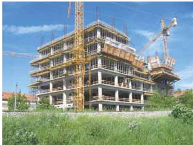
Uznapredovali armiranobetonski radovi
