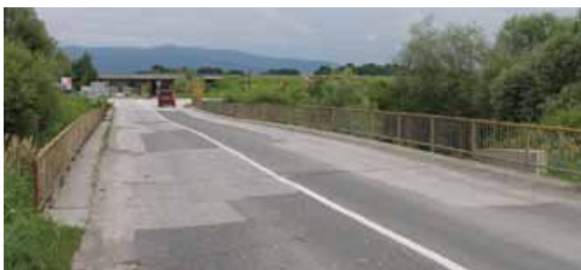
Slika 5. Prometna površina i ograde (Most 1)
