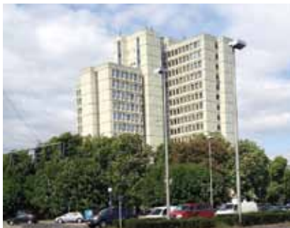
Zgrada Chromosa u Zagrebu u kojoj je sjedište HKIG-a
