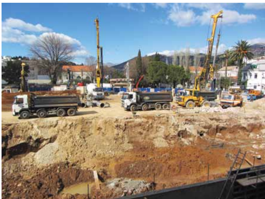
Bušenje pilota u građevnoj jami
