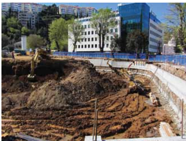
Zemljani radovi u građevnoj jami
