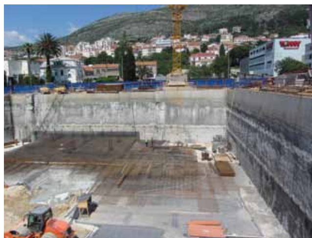
Betoniranje temeljne ploče i početak građenja
