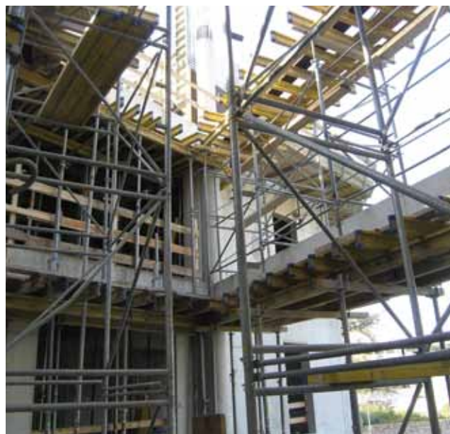
Gradnja nadzemnih dijelova građevina
