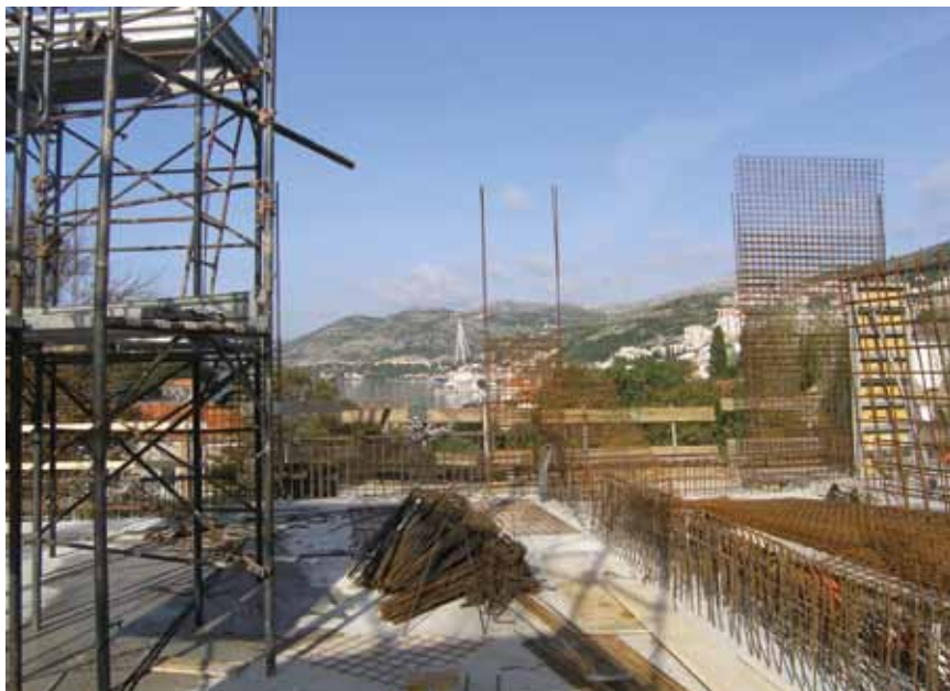
Radovi na vrhu gradilišta s pogledom na Grušku luku
