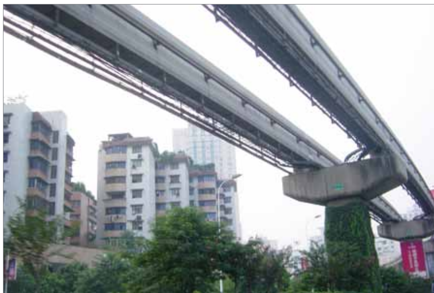
Nosači i stupovi gradske željeznice
