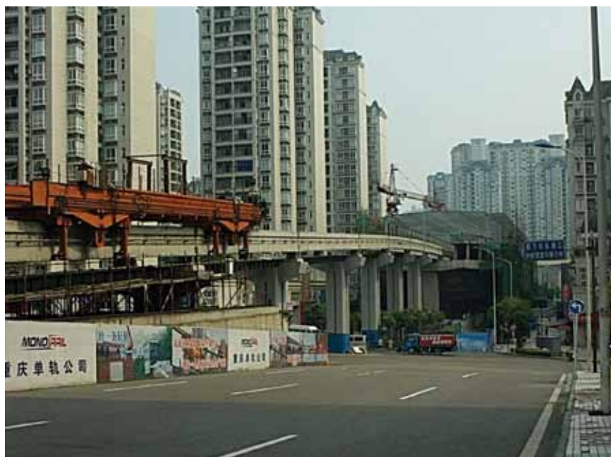
Gradnja nadzemnog dijela jednotračničke gradske željeznice
