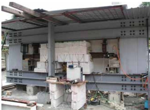
Slika 5. Prikaz peći s okvirom za unošenje opterećenja u čelični element
