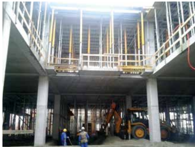
Radovi na gradilištu u studenom 2012.
