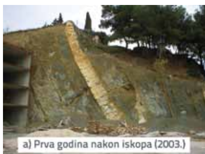
Slika 9. Primjer procjeđivanja vode kroz pukotine u flišu
