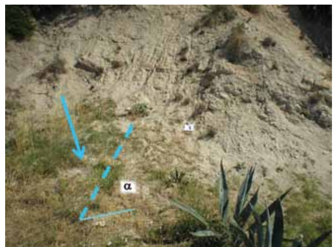
Slika 6. Izmjereni nagib pokosa deponiranog rastrošenog lapora na dnu kosina (strelica), u rasponu \alpha = 31^\circ do 38^\circ
