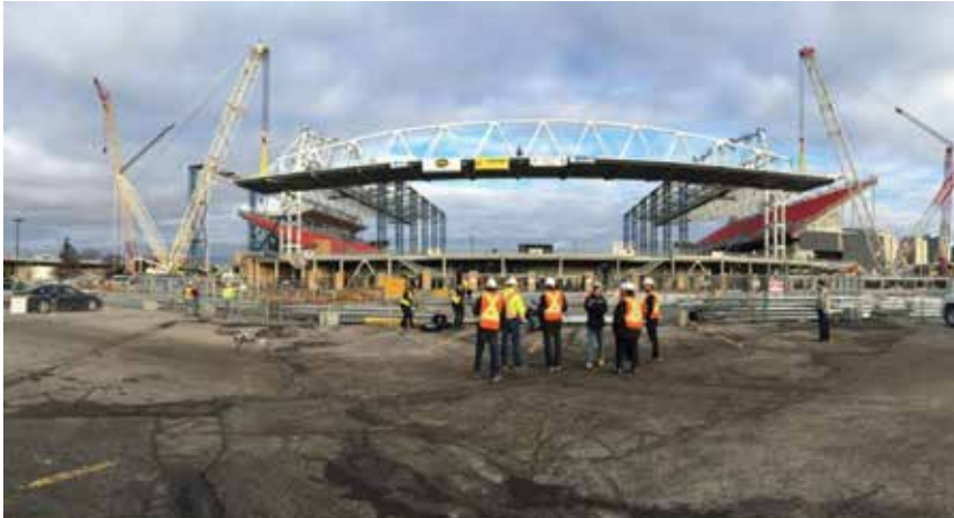
Podizanje južne nadstrešnice stadiona Toronto
