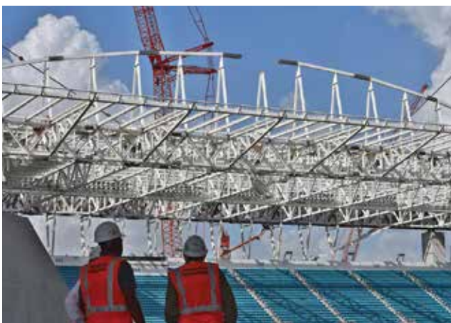
Detalj dugorasponske čelične konstrukcije krova stadiona Miami
