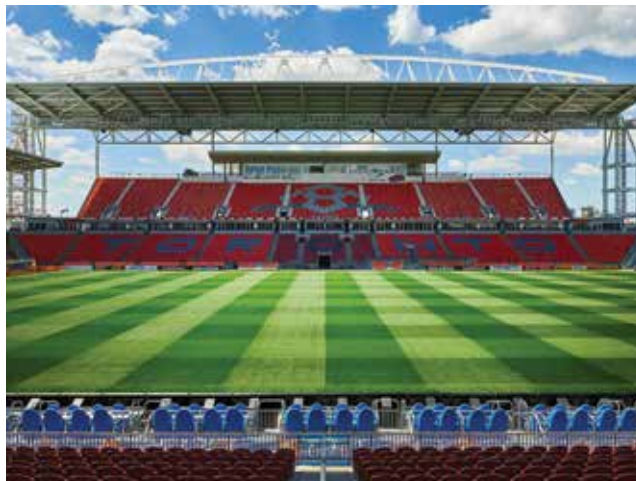
i pogled na čeličnu konstrukciju nadstrešnice zapadne tribine
