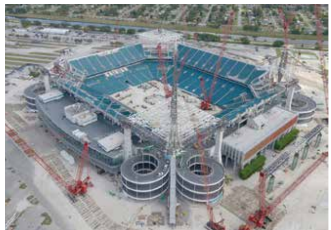
Izgradnja novog krovšta tijekom rekonstrukcije stadiona Miami
