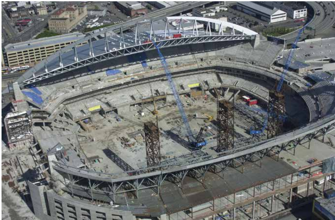
Gradilište stadiona Seattle snimljeno 2001.
