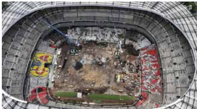
Detalj s gradilišta stadiona Mexico City
