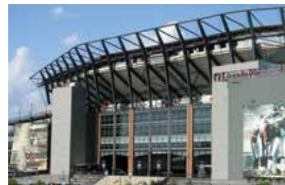
Detalj čelične konstrukcije i vanjskog pročelja stadiona Philadelphia
