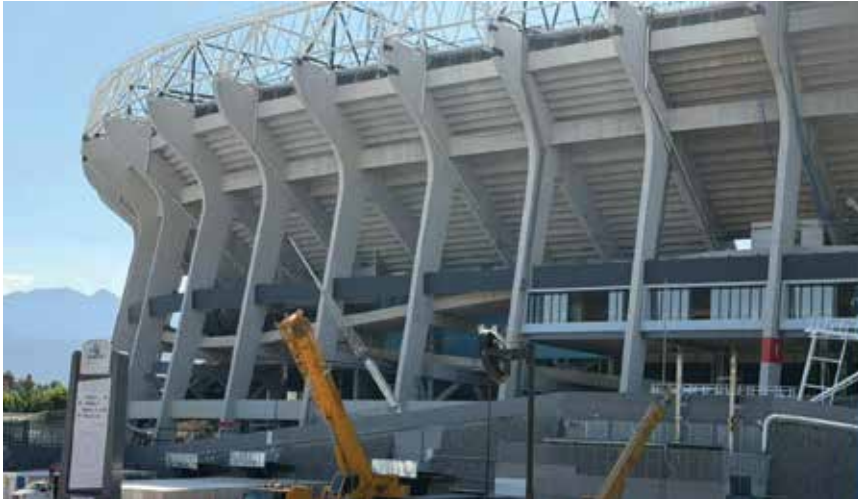
Pogled na armiranobetonsku konstrukcija u obliku zdjele stadiona Mexico City
