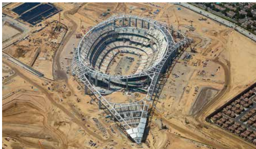
Gradilište armiranobetonske konstrukcije u obliku zdjele stadiona
