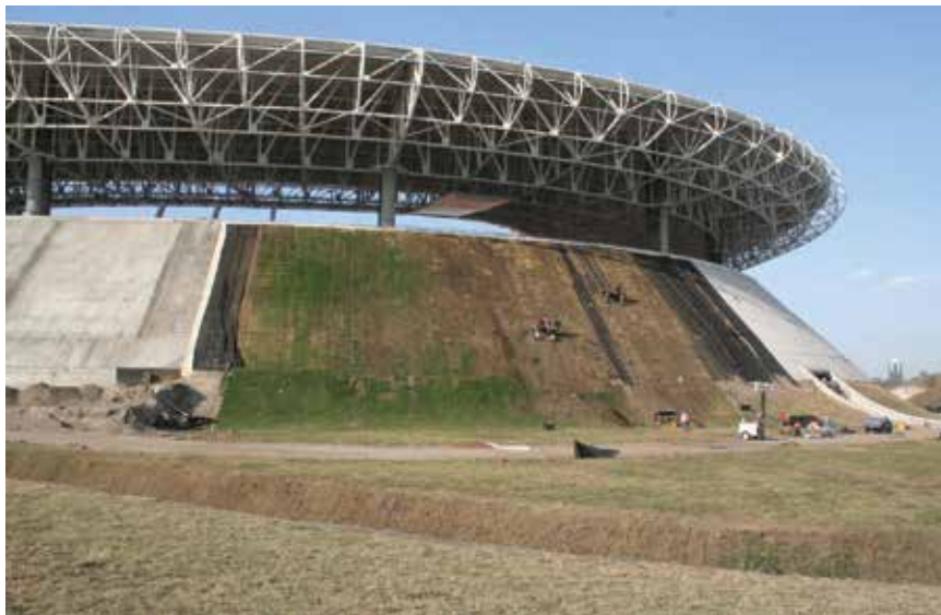
Gradnja berme oko stadiona
