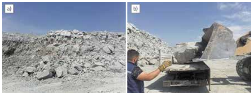
Slika 1. a) položaj stepenika iz koga se vadio blok stijene; b) utovar bloka stijenske mase
