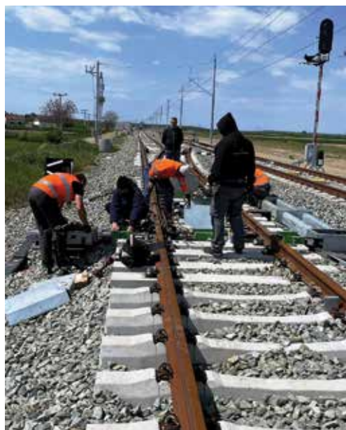
Ugradnja elektropostavne naprave
