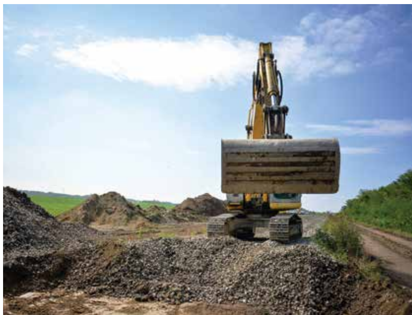
Radovi na kolosiječnom traku
