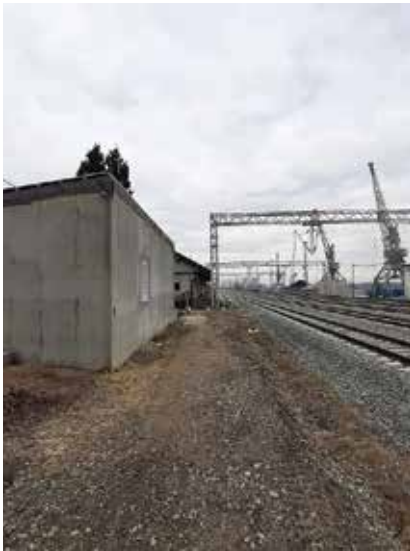
Kolosijeci i nova zgrada za smještaj signalno-sigurnosnih uređaja
