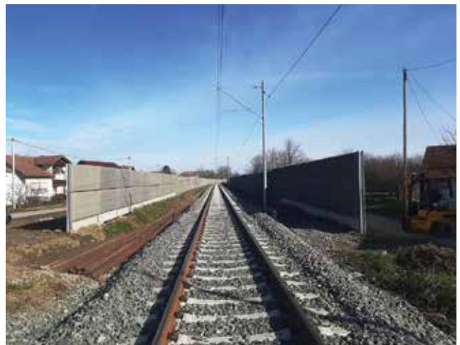
Zidovi za zaštitu od buke u Nuštru
