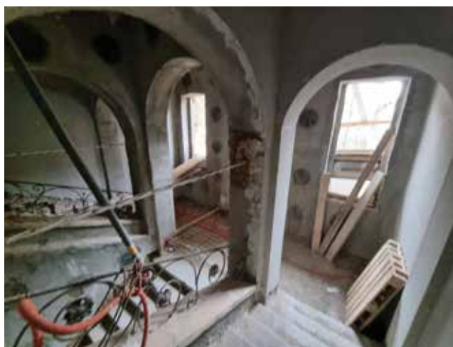
Detalji s gradilišta, ojačavanje postojećih zidova ulične zgrade
