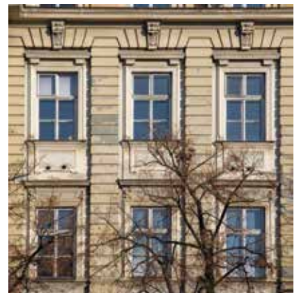
Detalj fasade prije obnove
