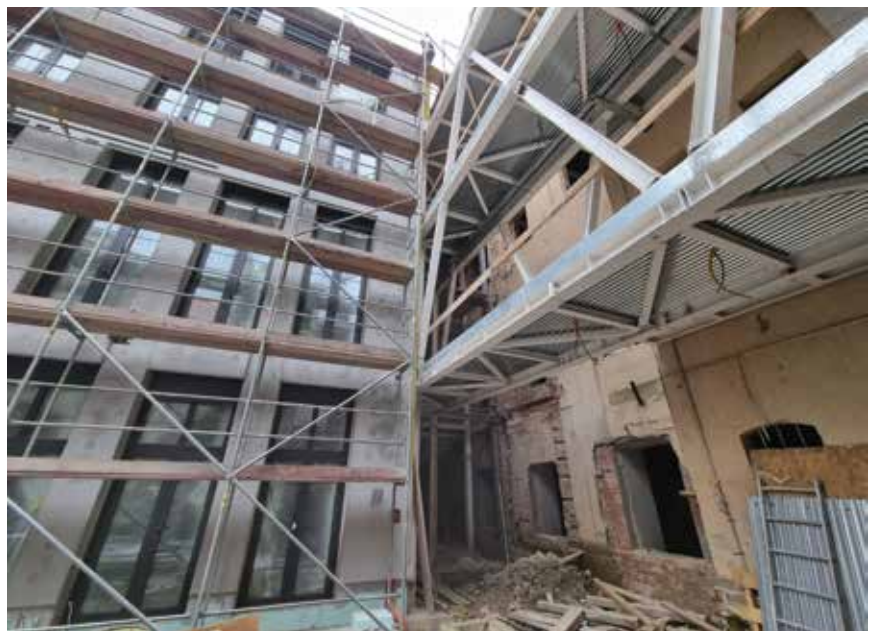
Izvedba spojnog mosta između ulične i dvorišnih zgrada
