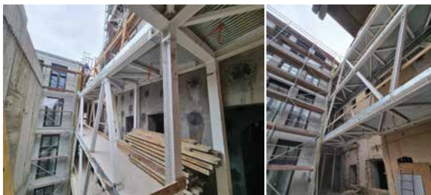
Detalj nove veze glavne i dvorišne zgrade
