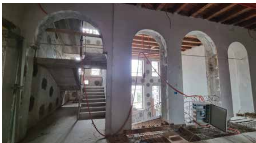
Spoj glavnog i dograđenog internog stubišta koje vodi od drugoga kata do novog izlaza na krov
