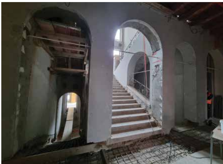
Radovi cjelovite obnove na uličnoj zgradi
