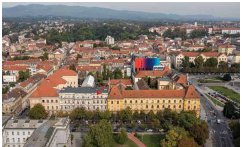
Pogled na zgradu Biološkog odsjeka PMF-a prije obnove
