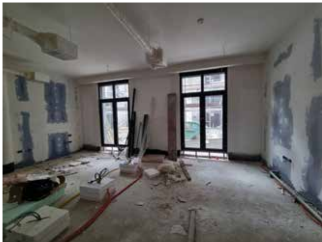
Novouređeni prostori istočne dvorišne zgrade
