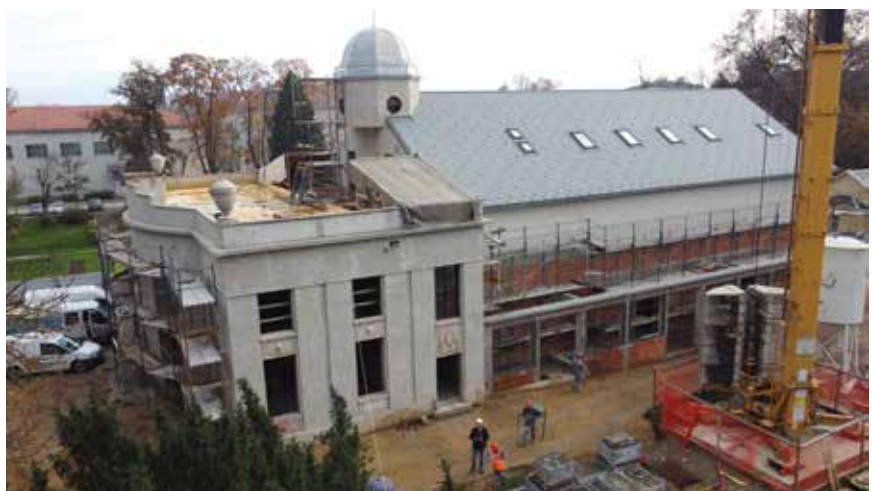
Detalj s gradilišta
