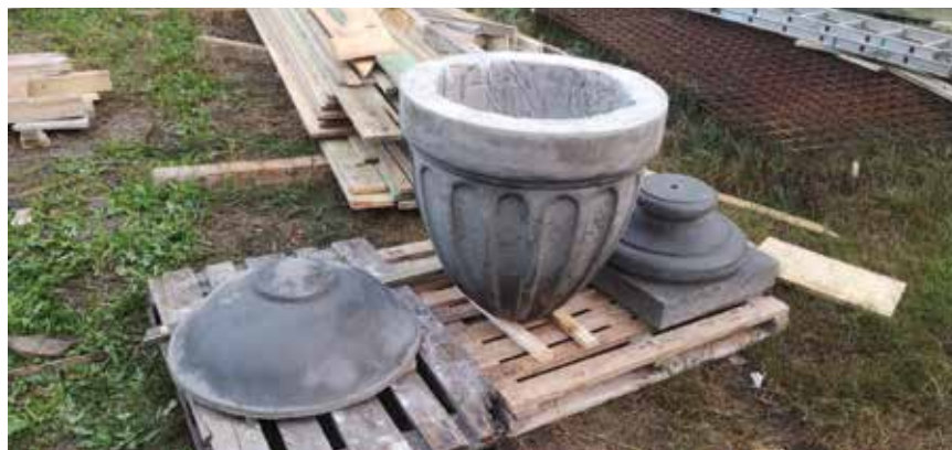
Novoizrađeni ukrasni art deco elementi istovjetni su starim, oštećenim elementima koje je trebalo zamijeniti
