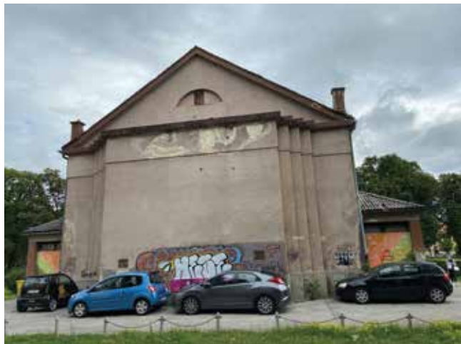
Zatečeno stanje zgrade kina prije rekonstrukcije
