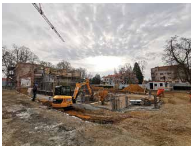
Izvedba novih temelja
