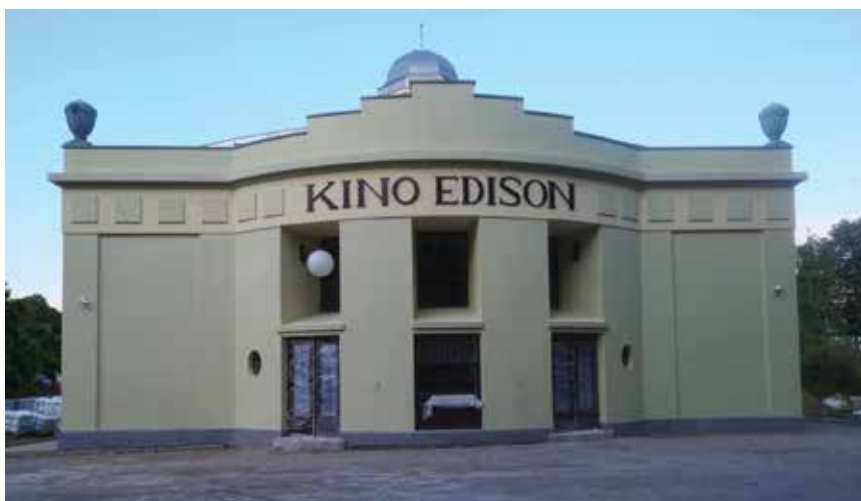
Pogled na ulazno pročelje prije i nakon rekonstrukcije
