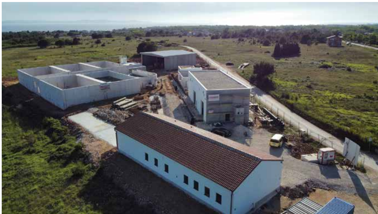
Gradilište UPOV-a Nin
