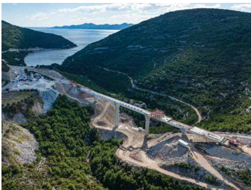
U tijeku su radovi na Stonskoj obilaznici (M.D./Cropix)
