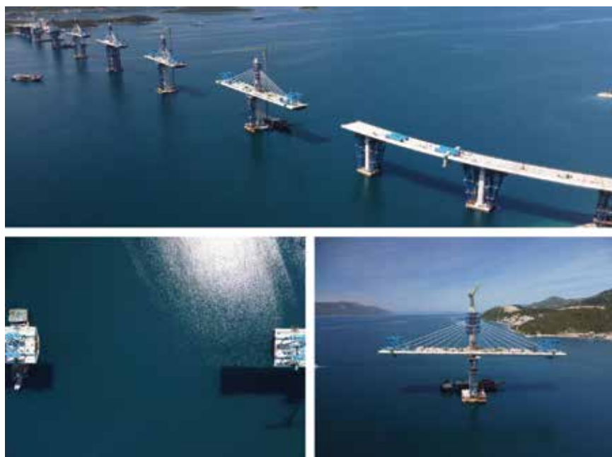
Detalji gradnje Pelješkog mosta (EdoStuff Aviation)
