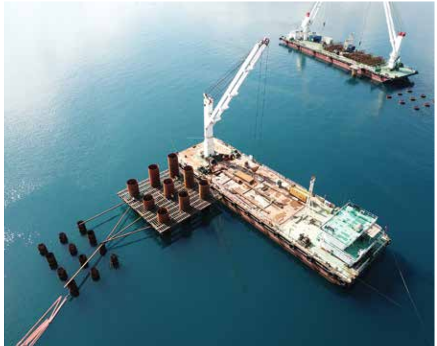
Temeljenje je bio najveći izazov u gradnji mosta (Hrvatske ceste)
