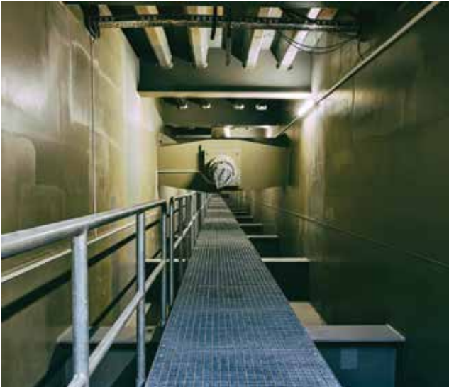
Pogled na unutrašnjost rasponskog sklopa mosta (Opis/Unimedia)
