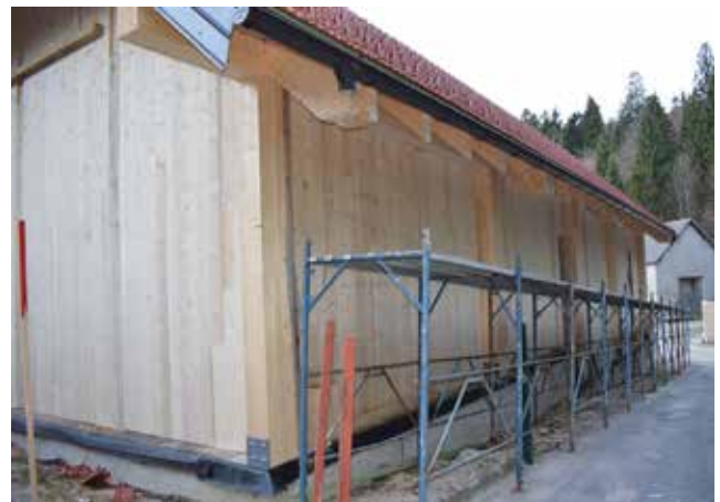
Pogled na drvenu konstrukciju nakon montaže svih konstrukcijskih elemenata
