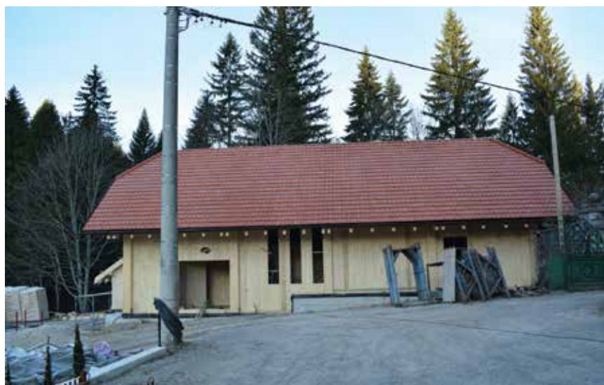
Pogled na gradilište
