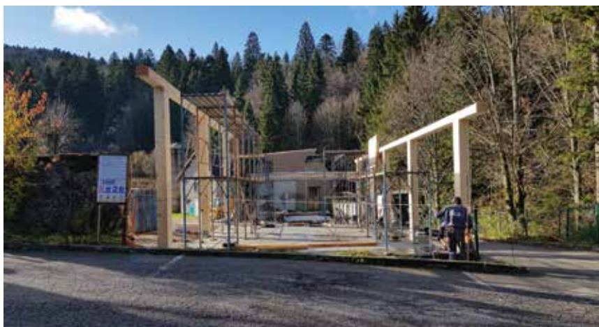
Detalj tijekom montaže drvenih elemenata konstrukcije
