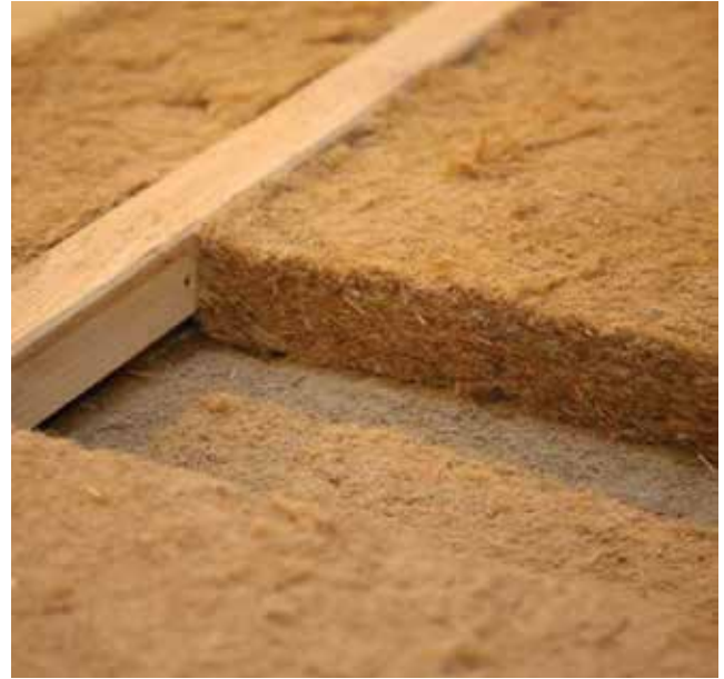
Cijela konstrukcija toplinski je izolirana drvenom vunom
