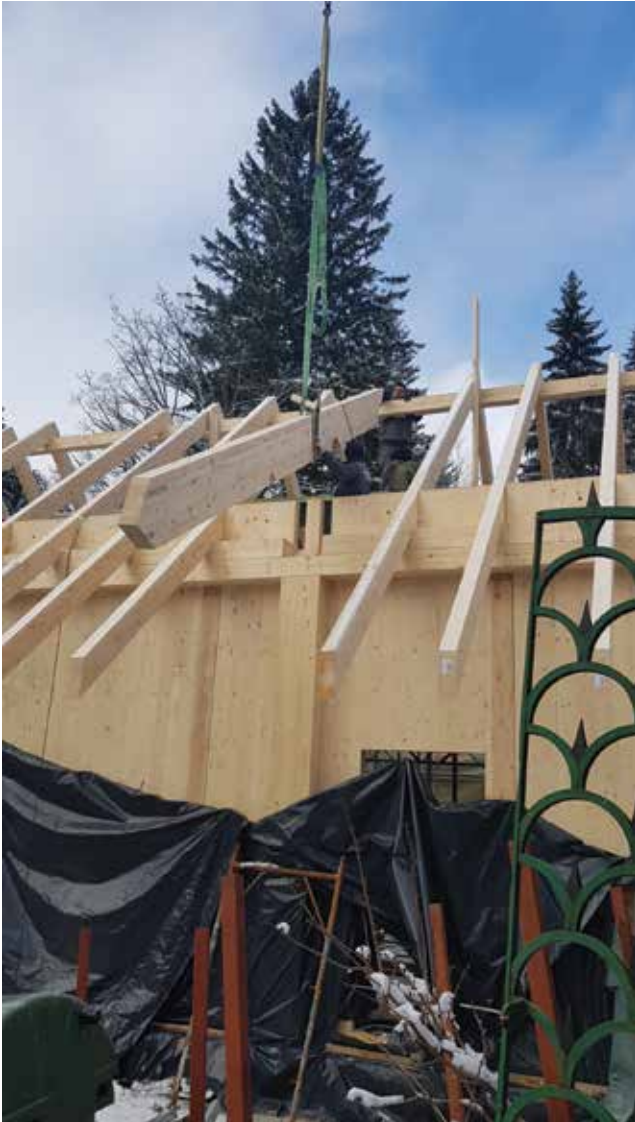
Krovni slojevi s toplinskom izolacijom oslonjeni su na rogove koji su postavljeni u razmaku od 80 centimetara
