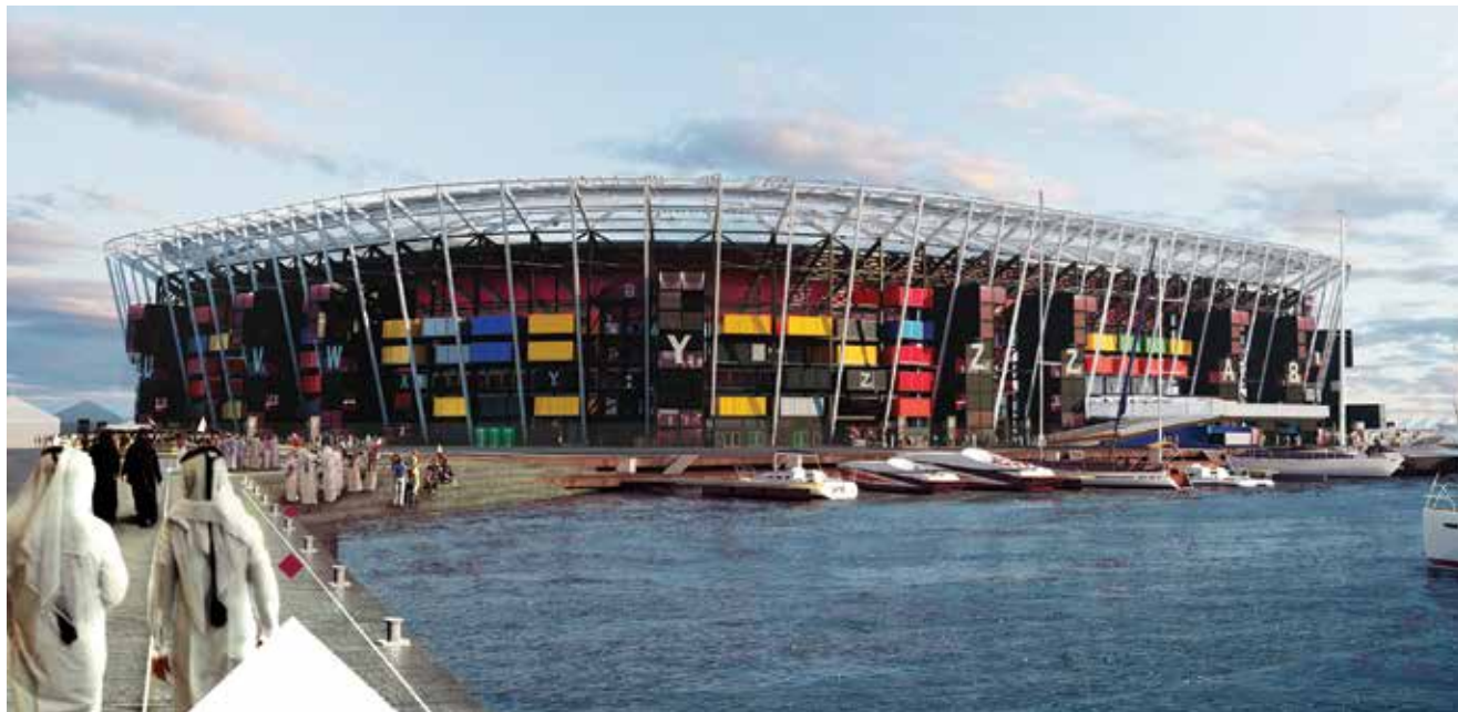
Stadion Ras Aboud gradi se modularnim načinom gradnje
