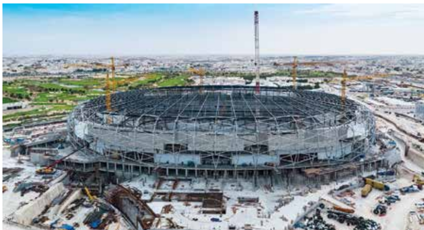
Detalj s gradilišta
