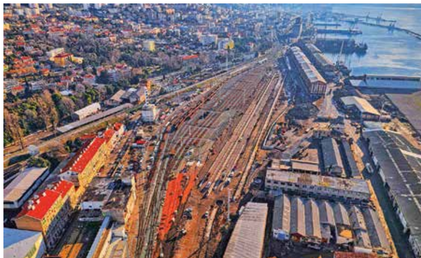
U trećoj etapi projekta izgrađeni su novi kolosijeci
