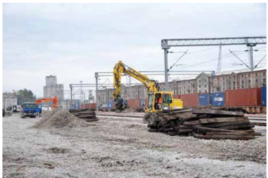
Detalj snimljen tijekom rekonstrukcije teretnog dijela kolodvora
