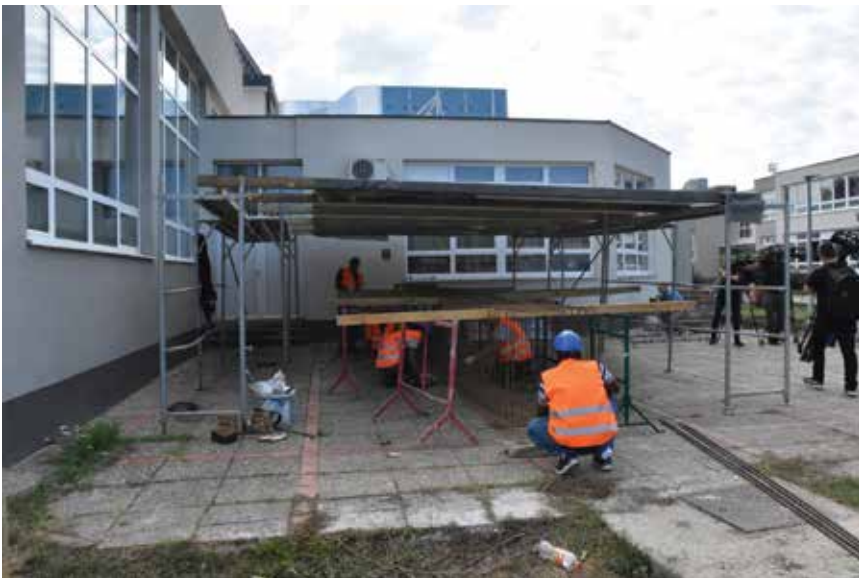
Prvi građevinski radovi na izgradnji centra kod Srednje strukovne škole Velika Gorica
