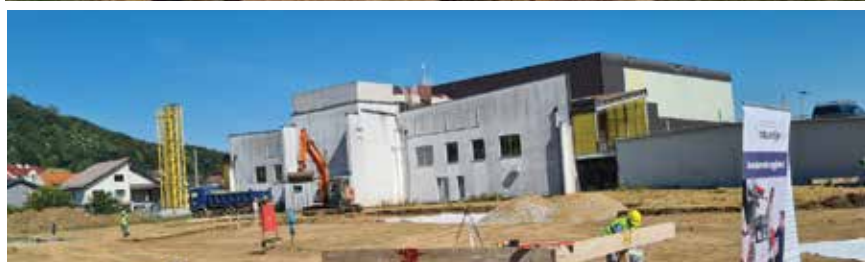
Detalj s gradilišta centra kompetentnosti u Samoboru
