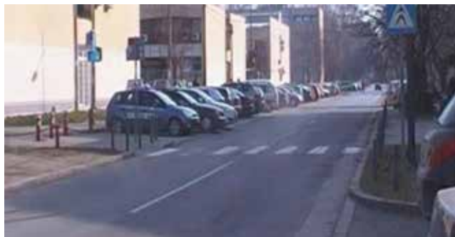
Slika 8. Pješački prijelaz prije rekonstrukcije
