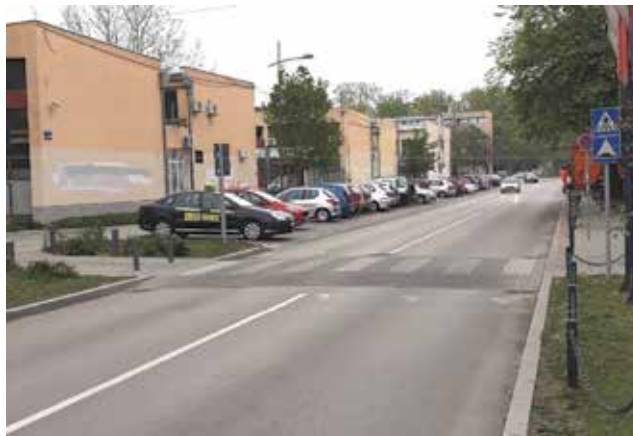
Slika 9. Pješački prijelaz nakon rekonstrukcije
