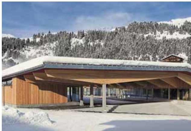
Slika 2. Hibridni LLN od smrekovine i jasenovine - garaža Innerarosa [5]
