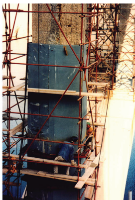
Slika 21. Ojačanje postojećih AB stupova na lučnom Paškom mostu u Hrvatskoj - poprečni presjek (lijevo) te fotografija izvedbe (desno), prema [77]
