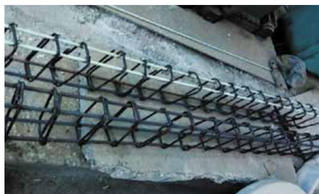
Slika 4. Detalji armiranja greda
