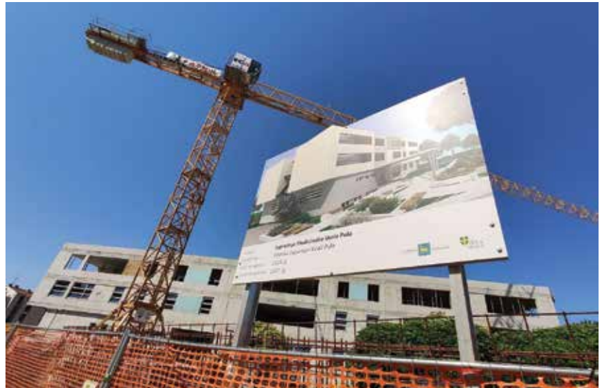
Gradilište Medicinske škole u Puli
