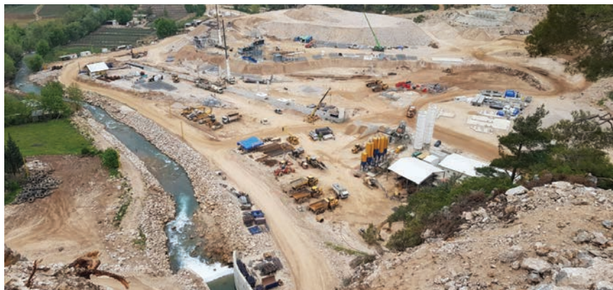
Pogled na gradilište
