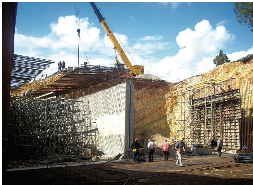
Detalj s gradilišta jednog od nadvožnjaka na autocesti
