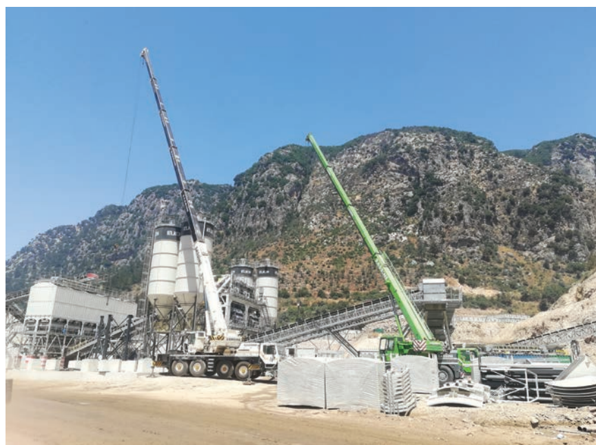
Montaža silosa na gradilišnoj betonari
