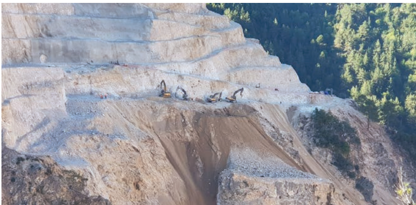
Detalj s gradilišta
