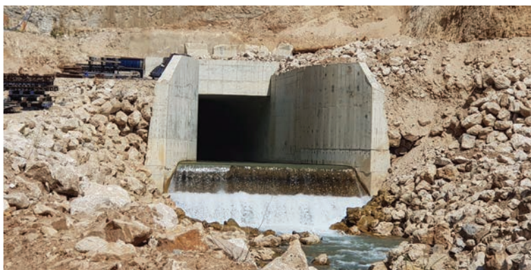
Izlazna građevina tunela za skretanje toka rijeke Nahr Ibrahim
