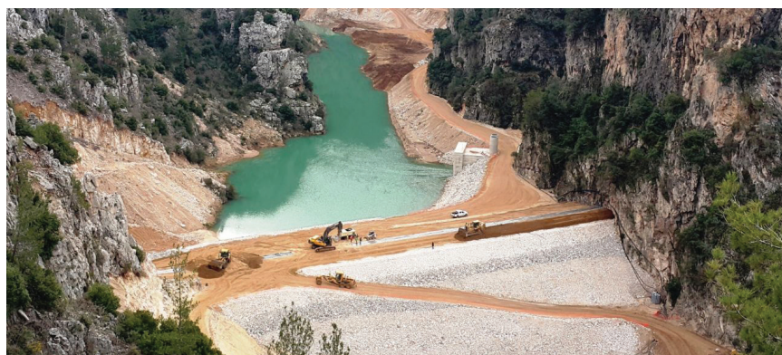
Detalj brane Janna Dam - privremena brana za skretanje rijeke Nahr Ibrahim u tunel
