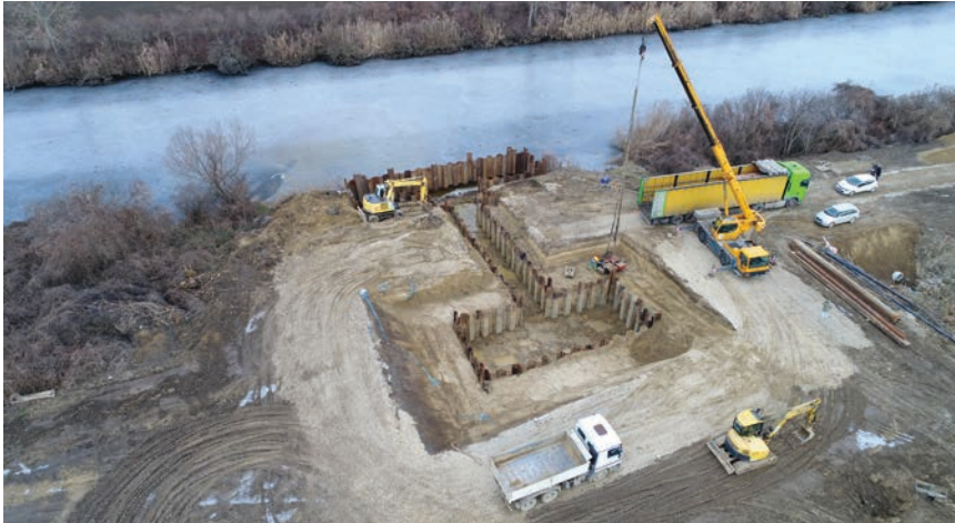
Izgradnja crpne stanice Sopot
