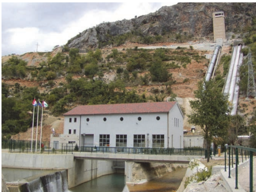
Pogled na strojarnicu i vodnu komoru HE Peć Mlini
