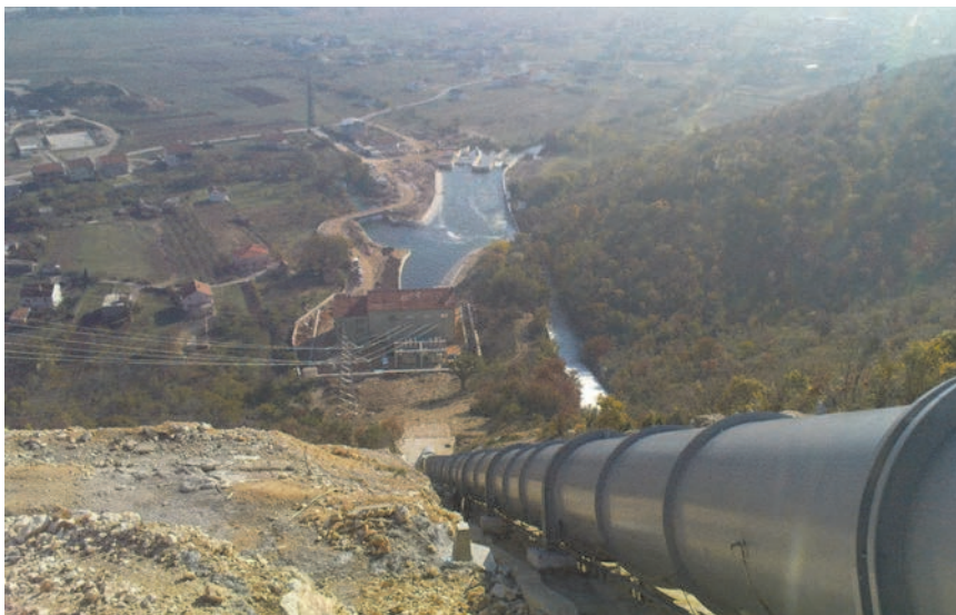
Pogled na strojarnicu HE-a Mostarsko blato s lokacije zasunske komore
