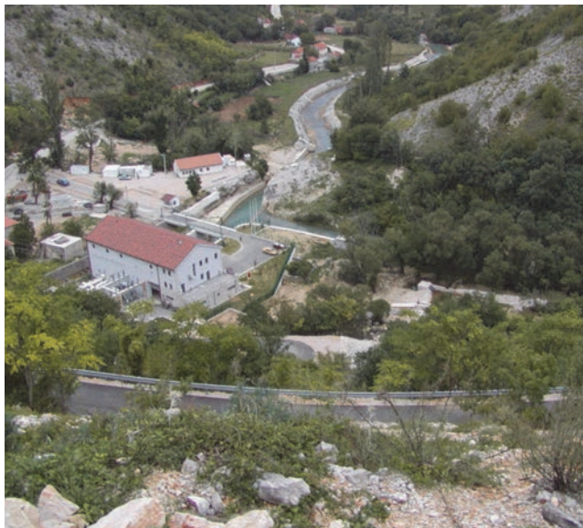
Pogled na strojarnicu HE Peć Mlini s lokacije vodne komore
