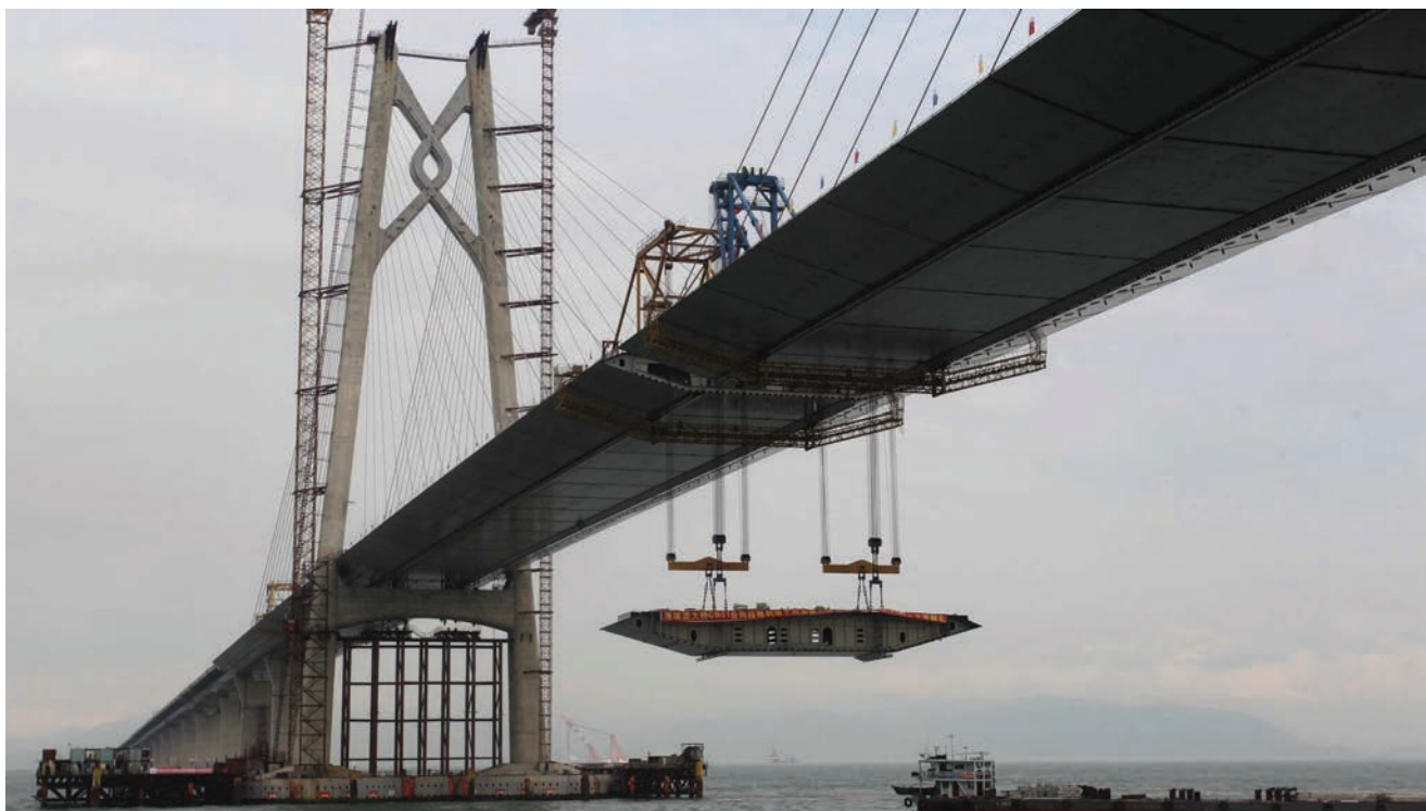
Montaža posljednjeg predgotovljenog elementa na mostu
