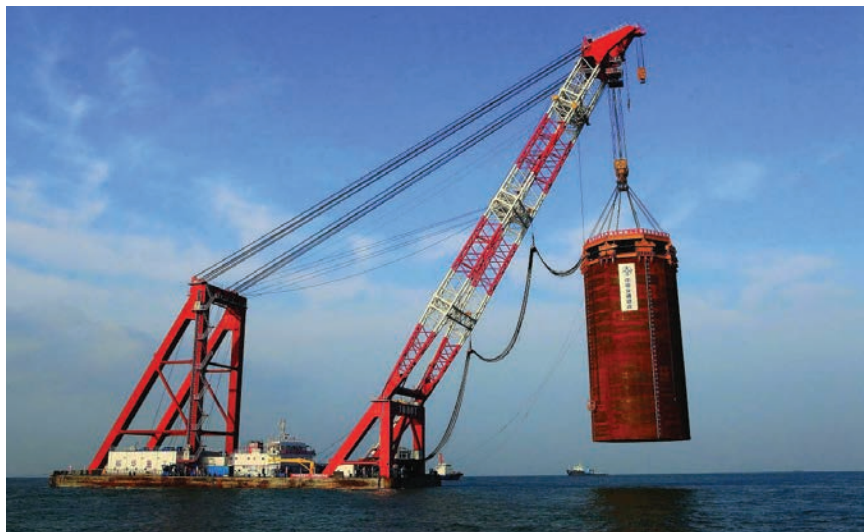
Postavljanje čeličnih pilota
