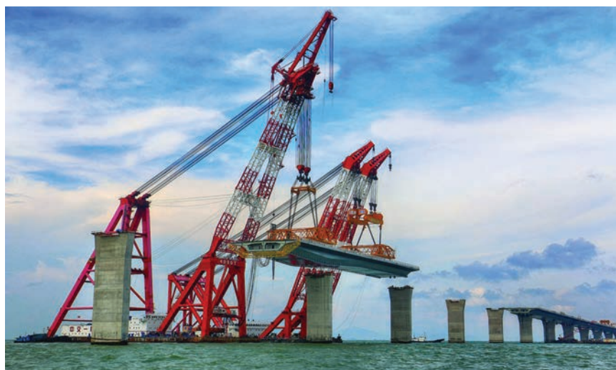
Montaža predgotovljenih betonskih elemenata mosta
