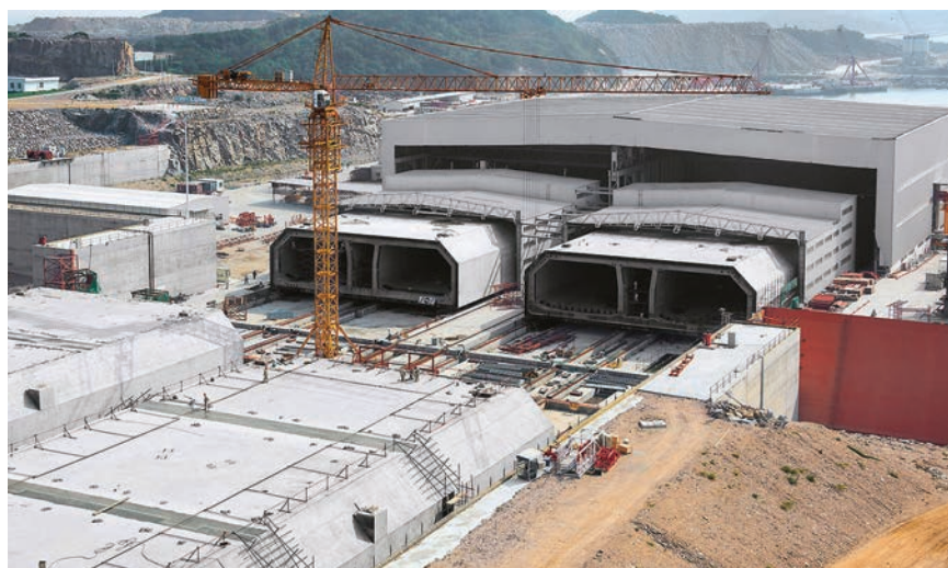
Proizvodnja predgotovljenih elemenata za uronjeni tunel
