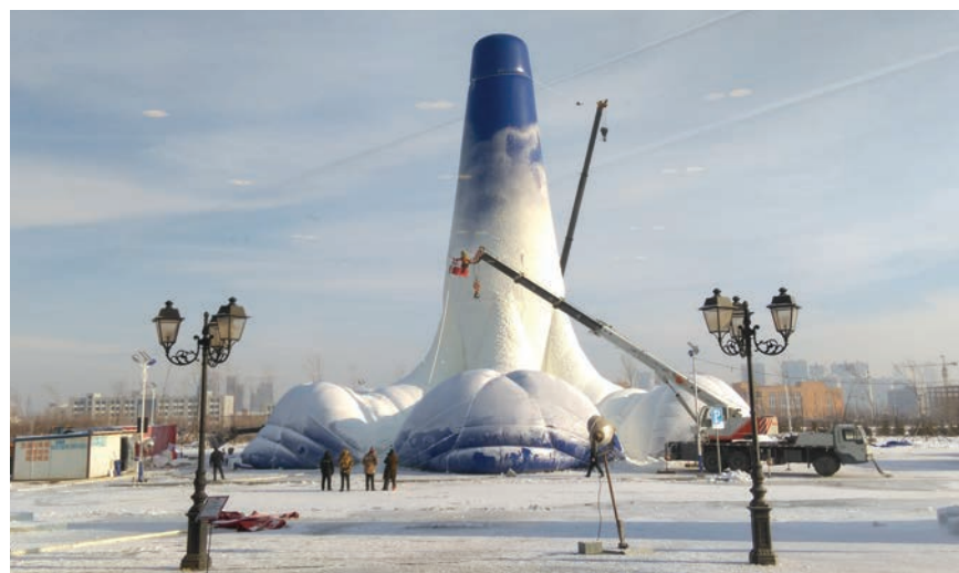
Nanošenje mješavine snijega, leda i drvenih vlakana na balon
