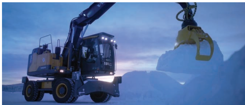
Dopremanje ledenih blokova na gradilište
