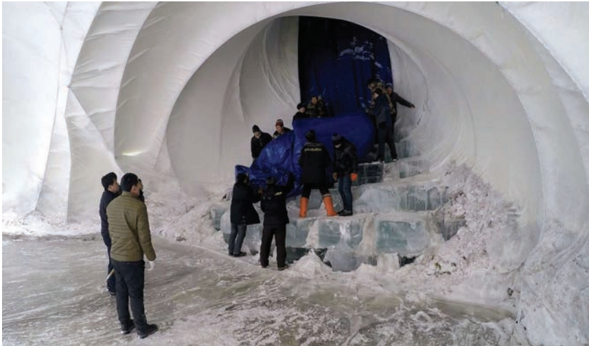
Uklanjanje balona nakon dovršetka gradnje
