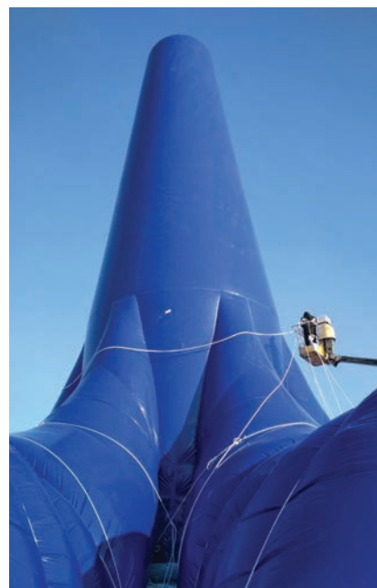
Postavljanje balona - kalupa za ledeni toranj
