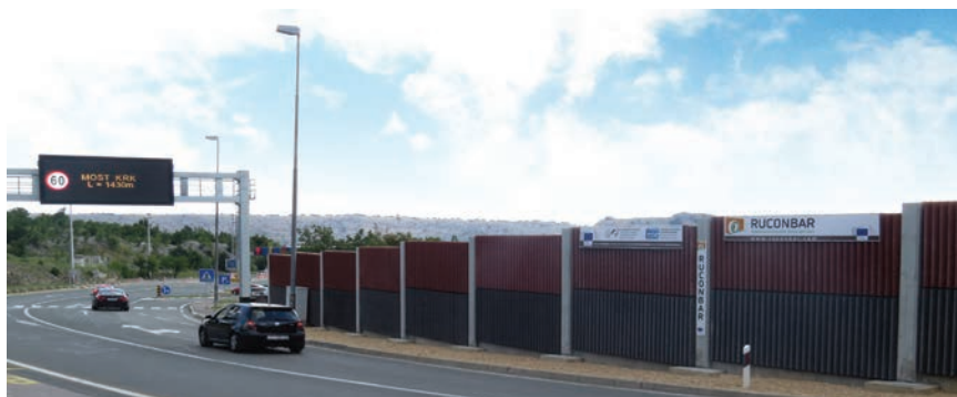
Prvo mjesto postavljanja barijere RUCONBAR na cesti prije Krčkog mosta
