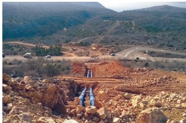
Gradnja I. etape magistralnog cjevovoda (prijelaz preko Svatske drage)
