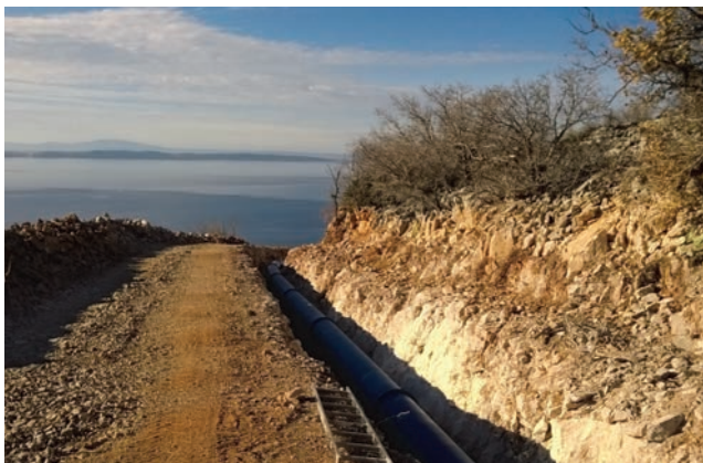
Gradnja I. etape magistralnog cjevovoda (dionica Bačvice – Koromačina)
