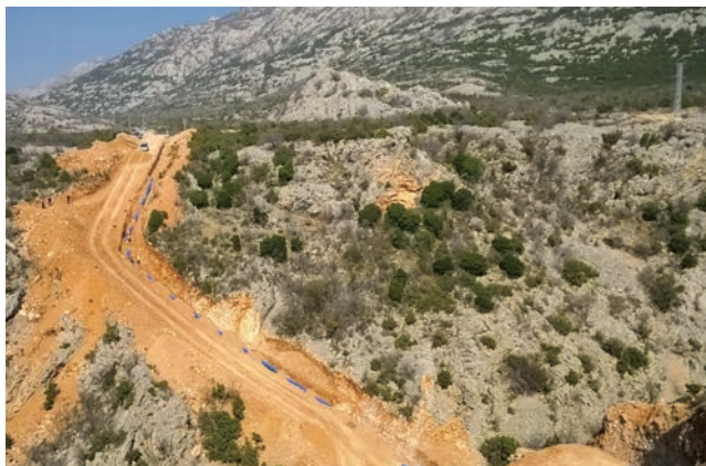
Gradnja II. etape magistralnog cjevovoda (prijelaz preko Vranjačke drage)
