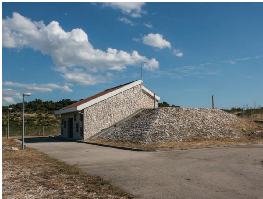
Zgrada crpne stanice Marići u zaleđu Zadra
