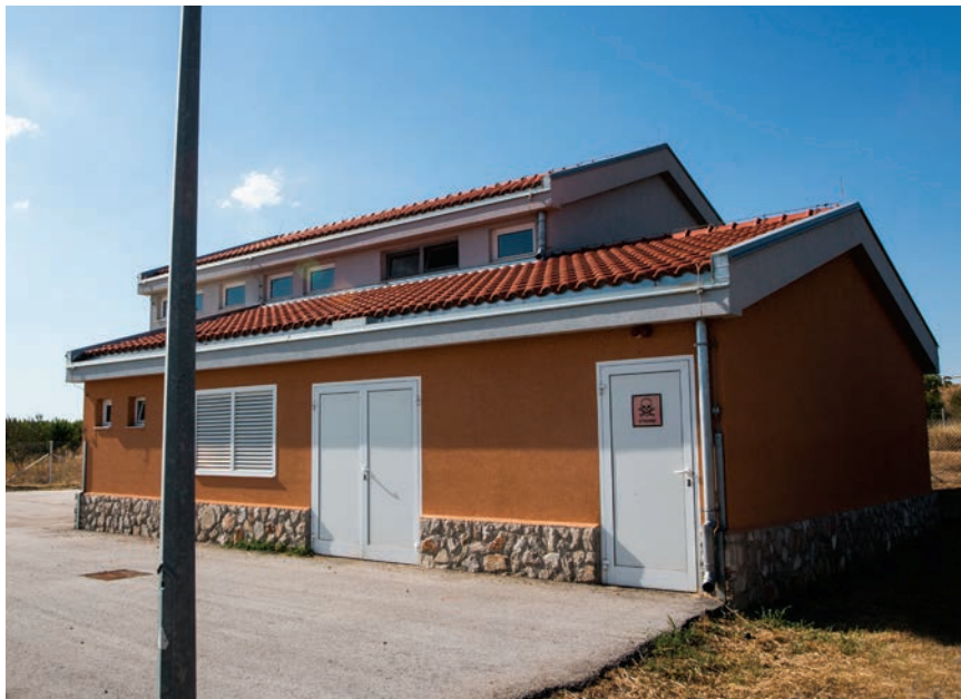
Zgrada crpne stanice Biljane Donje u zadarskom vodoopskrbnom sustavu
