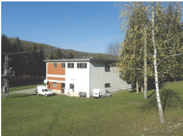
Zgrada uređaja za kondicioniranje vode na zahvatu Šumetlica
