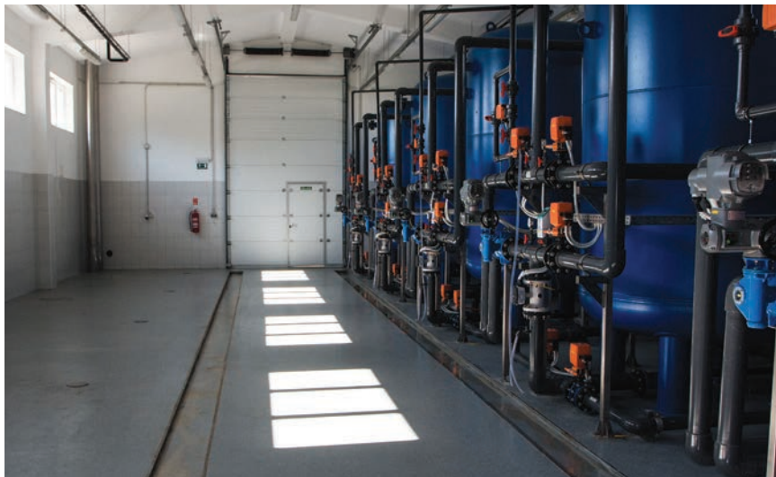
Novi pogon za preradu pitke vode na crpilištu Bikana u Virovitici
