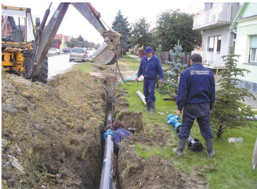
Polaganje cijevi distribucijskog cjevovoda u Đakovu
