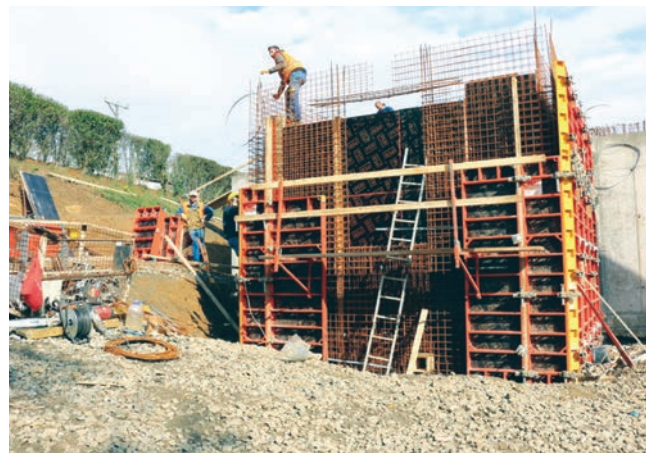
Gradnja novog vodospremnika Brodsko brdo 2
