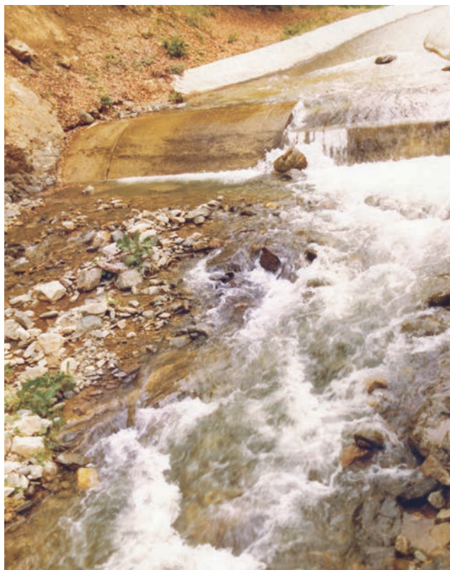
Prag preljeva na zahvatu Šumetlica tijekom gradnje 1977. godine
