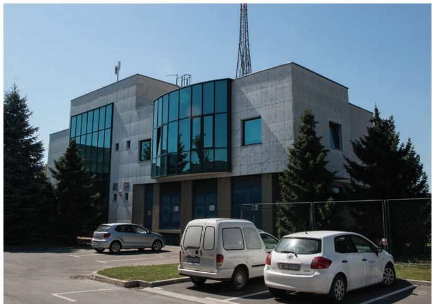
Suvremena distribucijska crpna stanica u sjedištu Vodovoda Osijek
