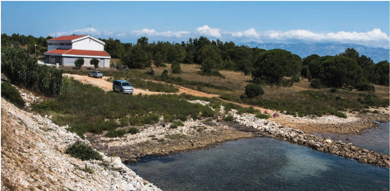
Priobalna zgrada crpne stanice Vir snimljena s mosta
