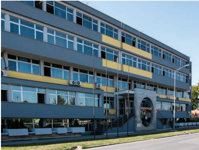
Upravna zgrada Vodovoda Osijek
