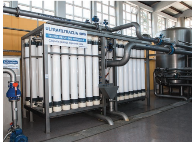
Uređaj za ultrafiltraciju u crpilištu Donji Miholjac
