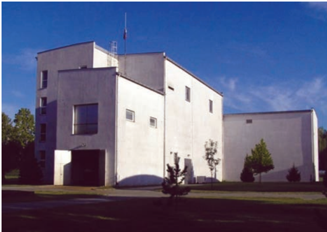
Zgrada crpilišta Jelas
