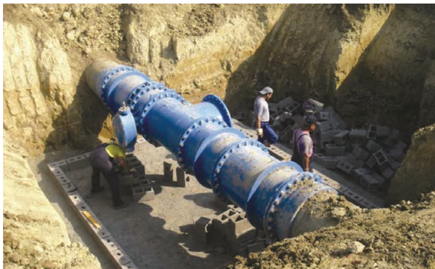
Detalj izgradnje temeljnog cjevovoda Županja – Babina Geda
