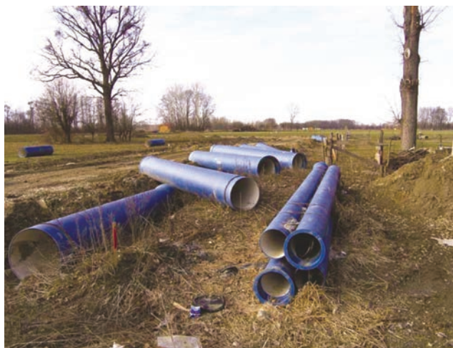
Cijevi na prostoru crpilišta u početku građenja
