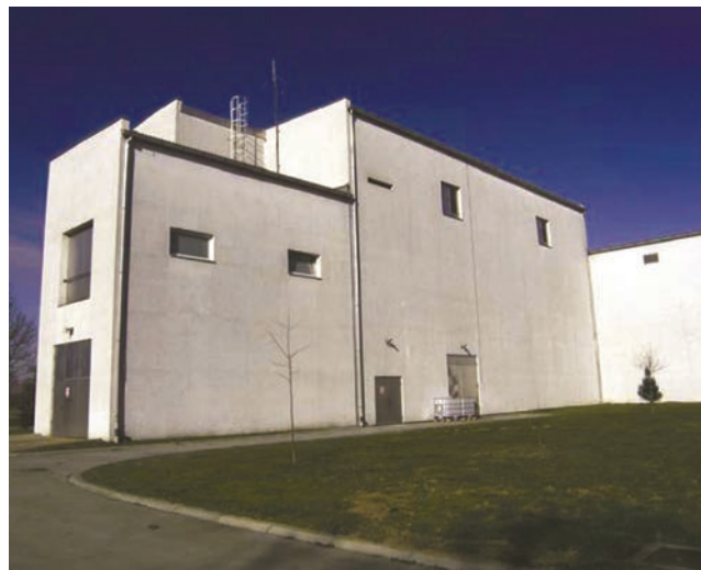
Postrojenje za kondicioniranje vode Jelas u Slavonskom Brodu
