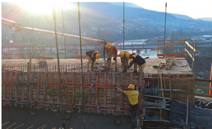
Prikaz montaže MSS skele na gradilištu
