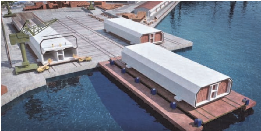
Slika 13. Izvlačenje gotove cijevi na syncrolift [12]
