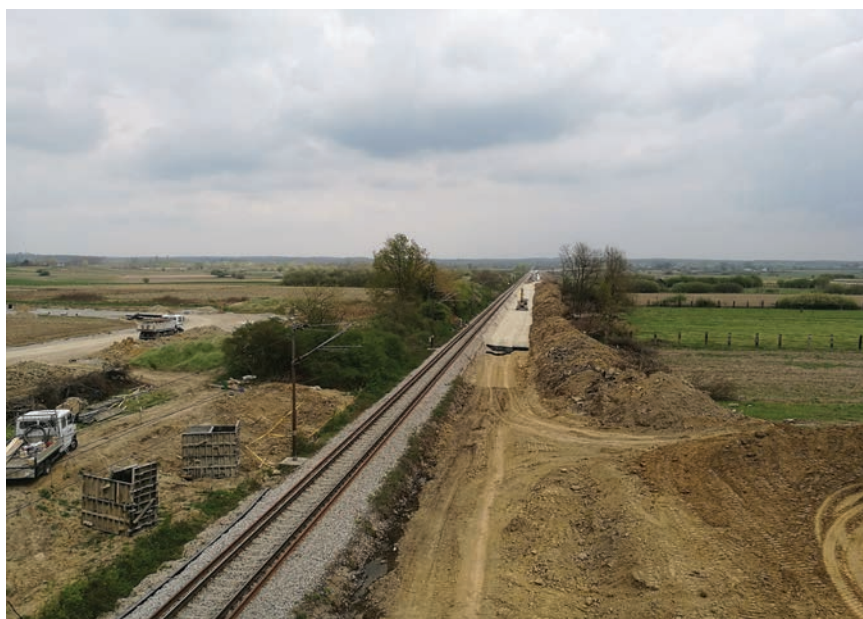
Zemljani radovi na gradilištu
