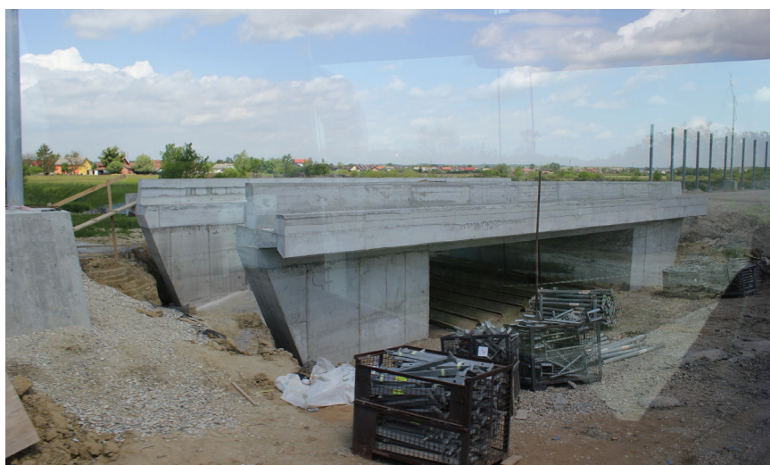
Izrada klinova uz most na devijaciji ispred kolodvora Vrbovec
