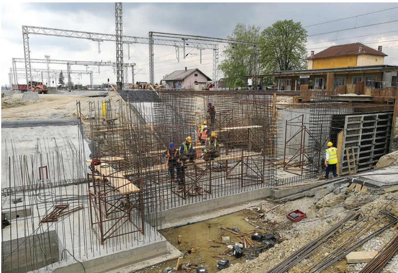
Izgradnja pothodnika u kolodvoru Vrbovec
