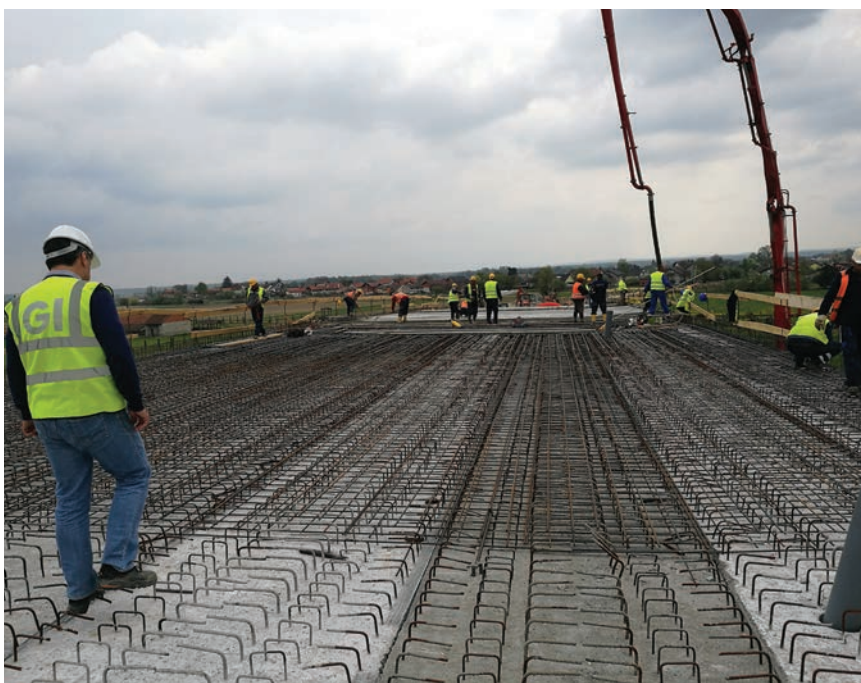
Izvođenje armiranobetonskih radova na nadvožnjaku br. 8
