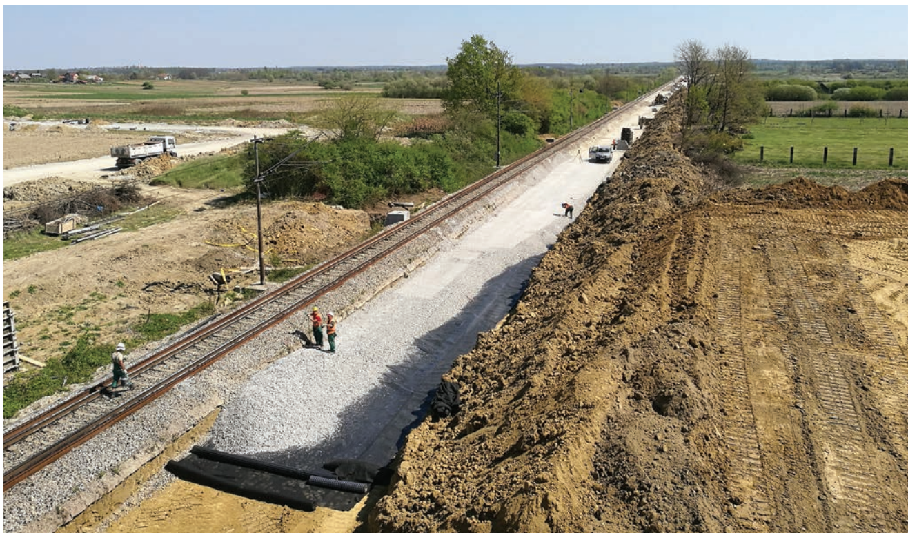
Izrada donjeg ustroja pruge, drugog kolosijeka, dionica Vrbovec - Križevci
