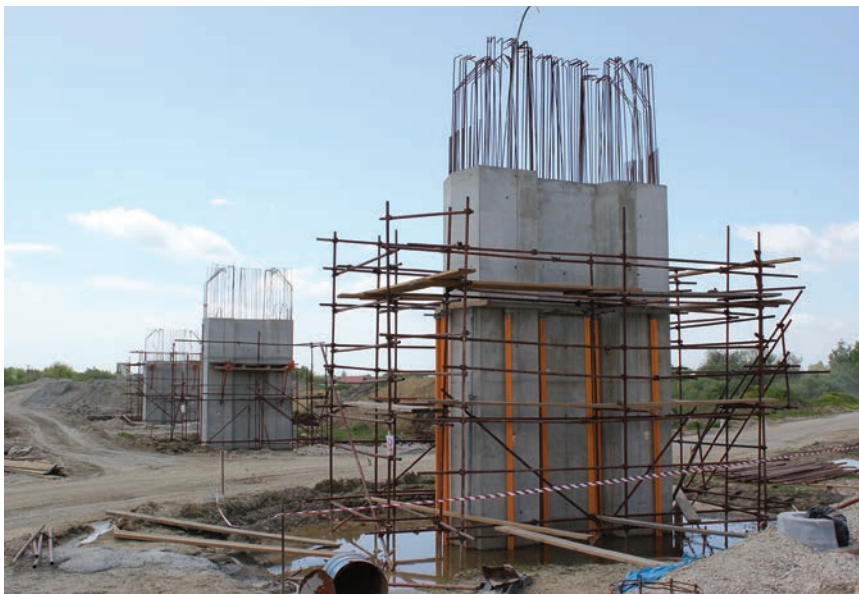
Izrada skele za izradu poprečnih nosača na nadvožnjaku br. 7 (KŽ 7)
