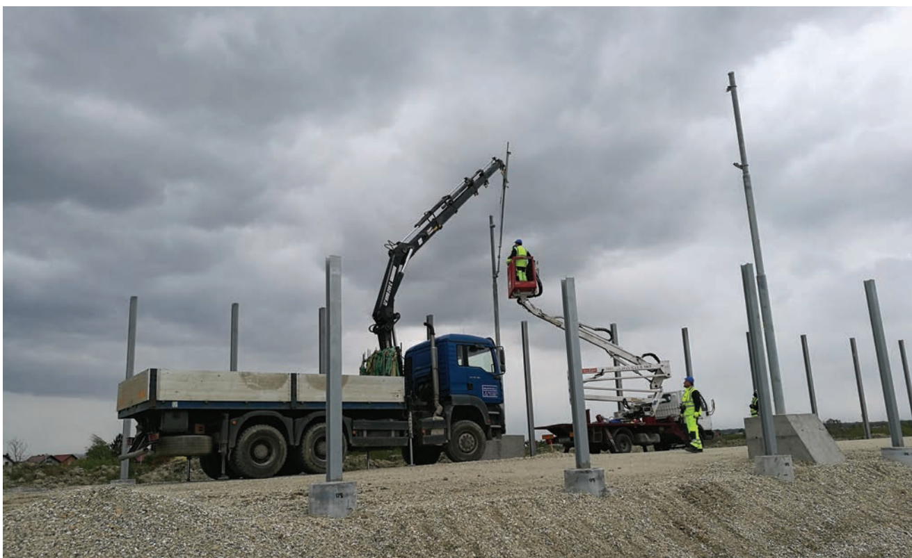
Detalj s gradilišta
