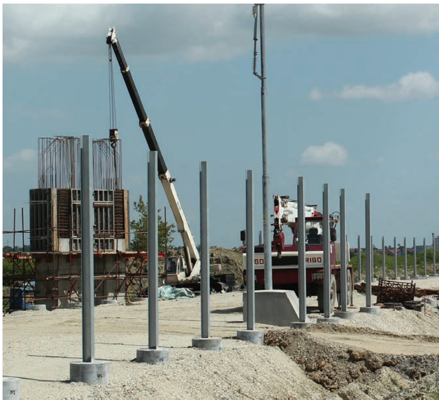
Postavljanje oplata autodizalicom na nadvožnjaku br.7 (KŽ 7)
