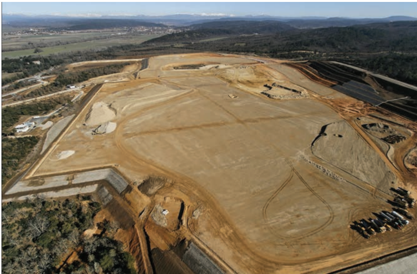
Gradilište nakon završetka pripremnih zemljanih radova
