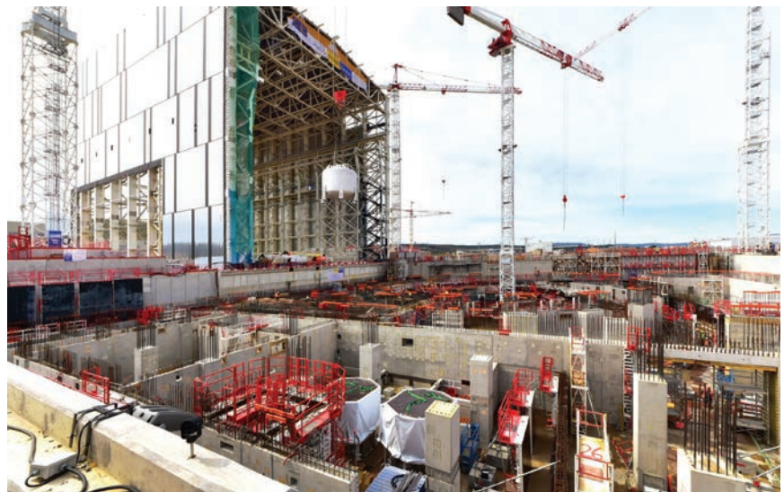
Pomoćna zgrada u kojoj će se instalirati rashladni uređaji
