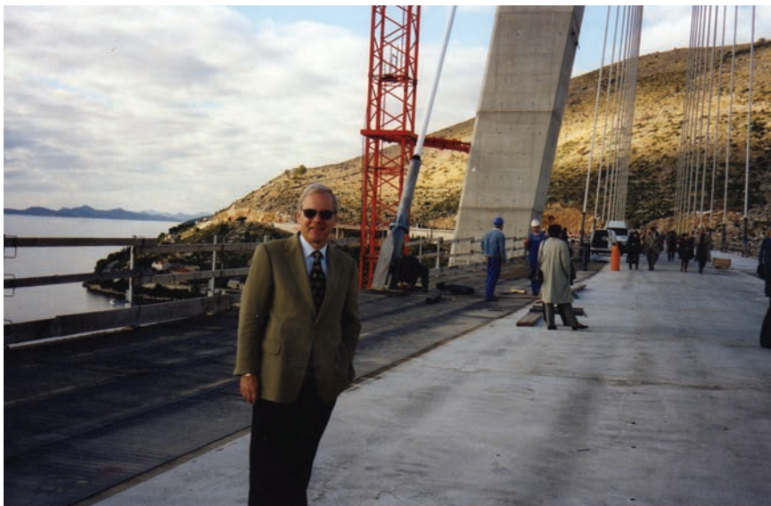
Na gradilištu mosta preko Rijeke Dubrovačke
