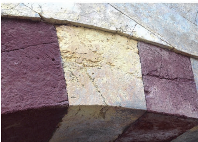
Slika 4. Prikaz manjih i većih pukotina na tornju u provinciji Gümüşhacıköy
