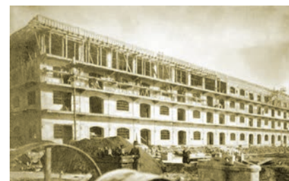
Kompleks Metropolis tijekom građenja
