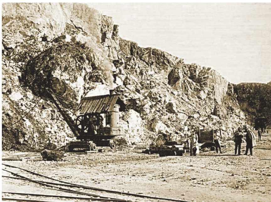
Kopanje materijala na Kantridi za nasipavanje prostora za gradnju luke
